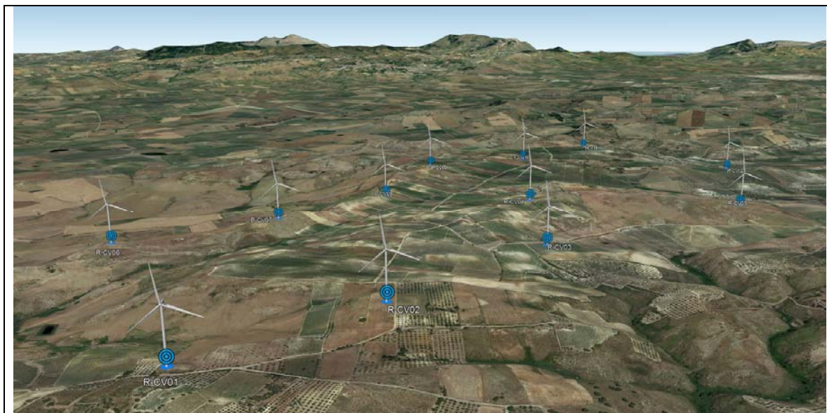
Vista degli aerogeneratori R-CV01 (in primo piano) e a seguire R-CV02, R-CV03, R-CV04, R-CV05, R-CV12. In secondo piano sono visibili gli aerogeneratori di cui alla successiva immagine
