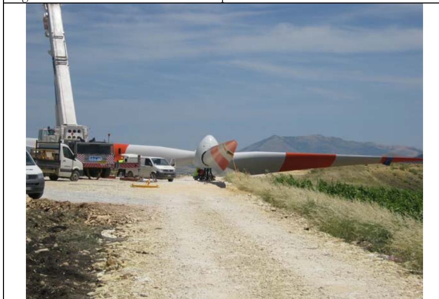
Particolare del supporto in acciaio su cui è collocato il rotore – Fonte HE
