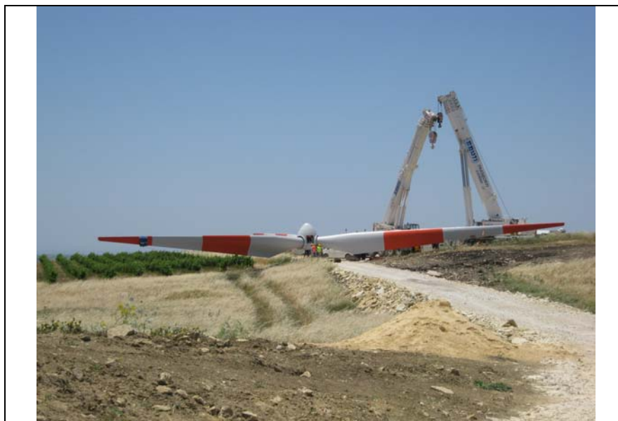
Ingombro reale di un rotore di diametro pari a 52 m – Fonte HE
