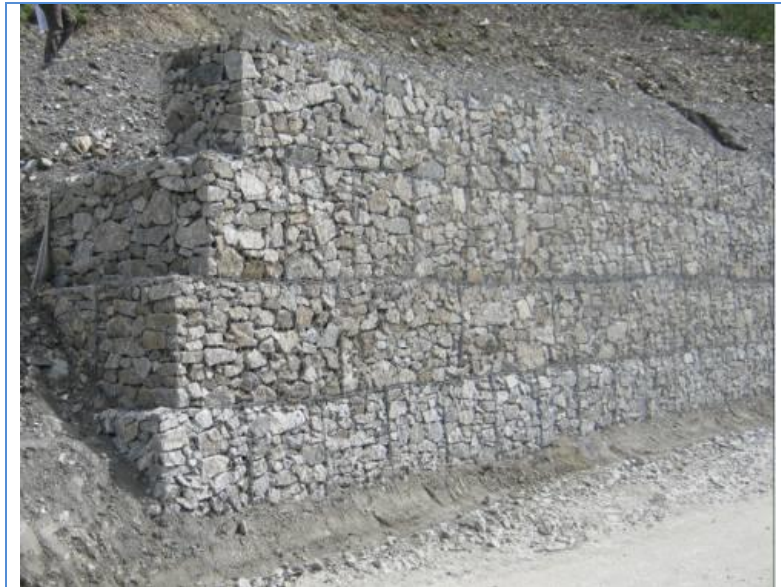
Esempio di opera in gabbioni - Fonte HE
