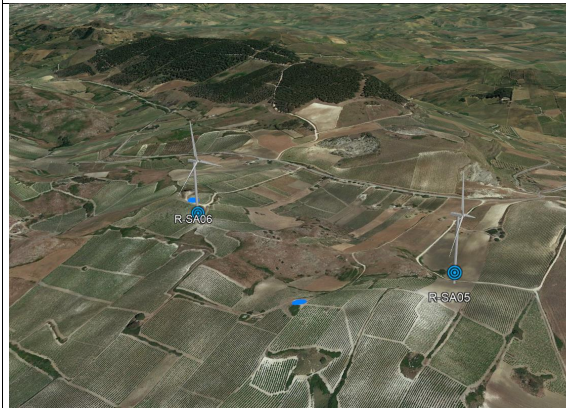
Vista degli aerogeneratori R-SA05, R-SA06
