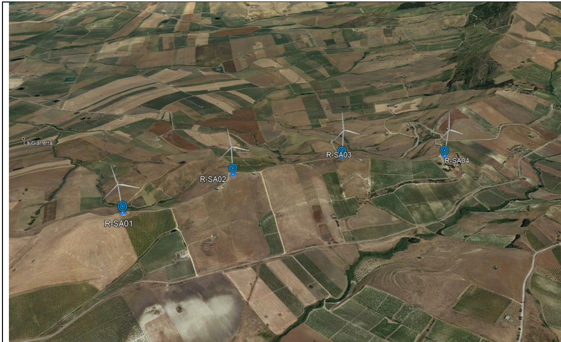
Vista degli aerogeneratori R-SA01, R-SA02, R-SA03, R-SA04
