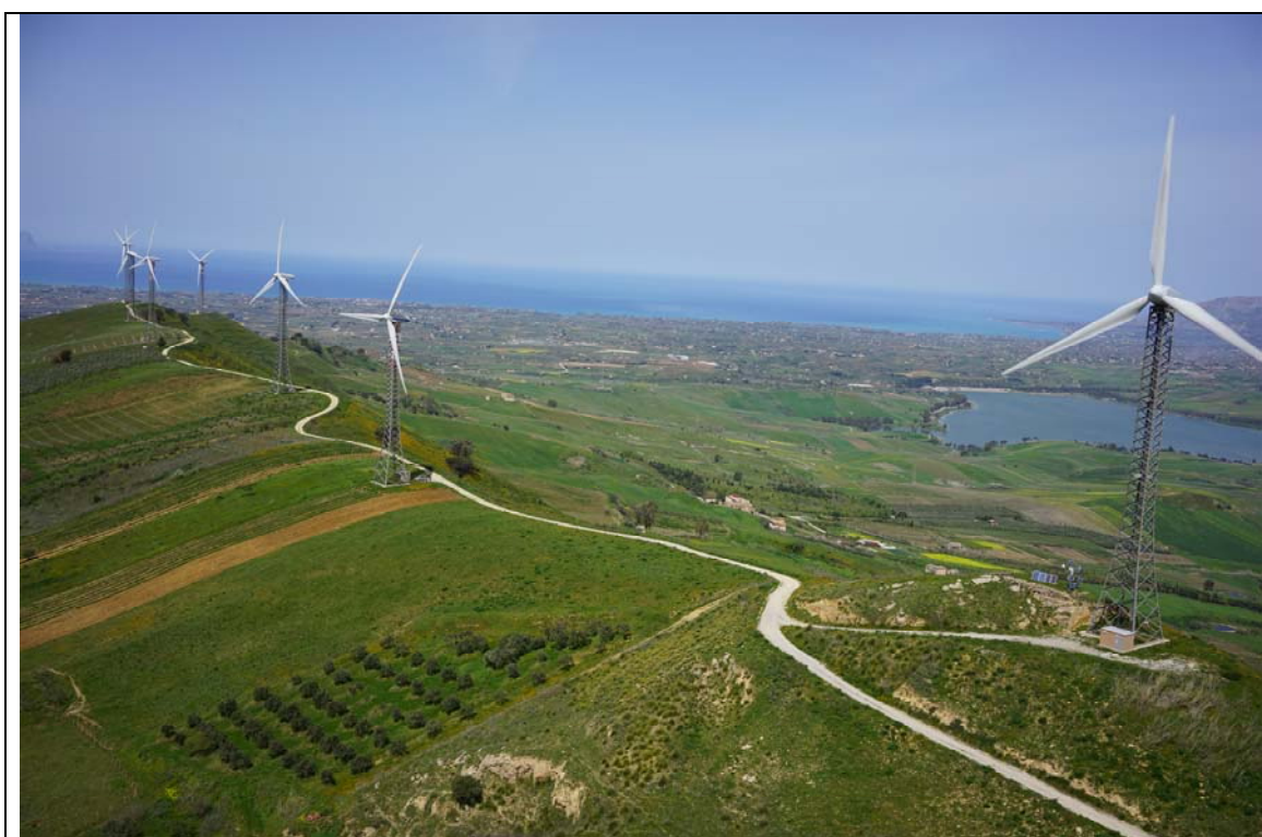
Panoramica di parte del parco eolico esistente acquisita con Drone – fonte HE
