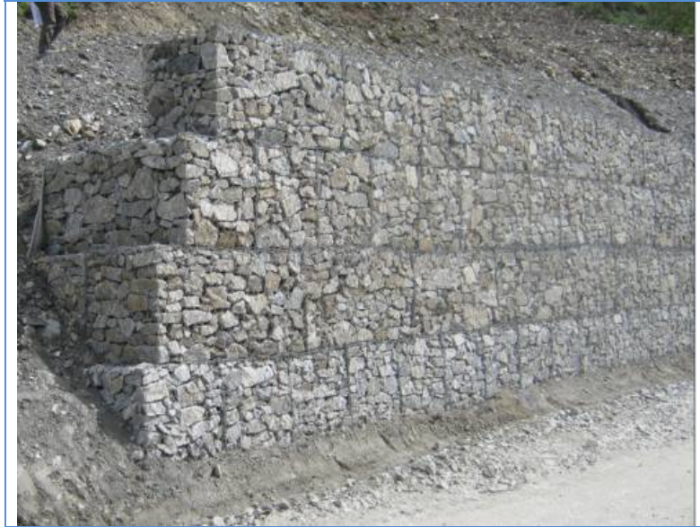
Esempio di opera in gabbioni - Fonte HE
