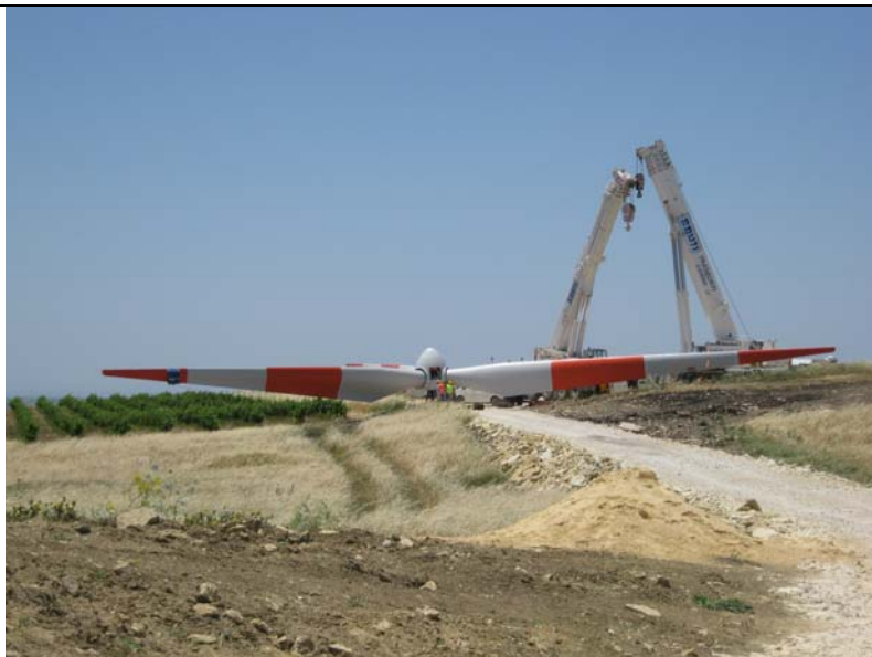
Ingombro reale di un rotore di diametro pari a 52 m – Fonte HE
