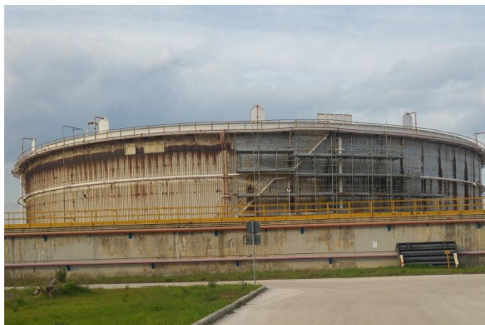
Figura 2 Il serbatoio di OCD in fase di smantellamento.
