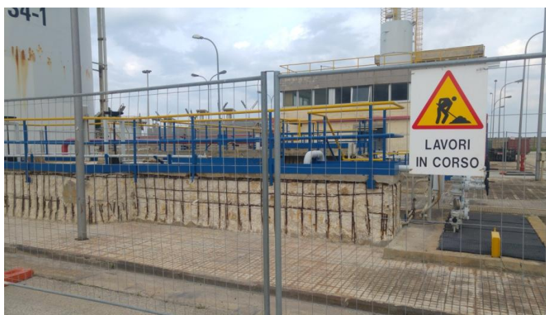
Figura 3 L'impianto ITAR in manutenzione straordinaria
