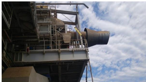
Figura 2 I camini dei motori diesel e del combustore
