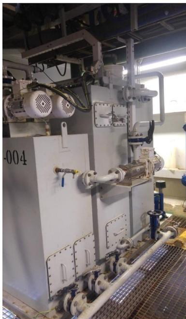
Figura 1 Il depuratore delle acque reflue civili
