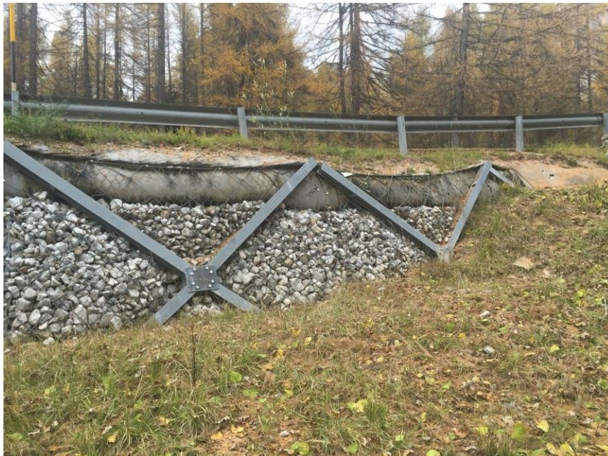
*Figura 6-7: Particolare delle opere di protezione e stabilizzazione della strada*
