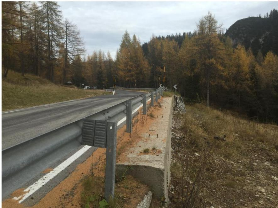
*Figura 6-9: Particolare delle opere di protezione e stabilizzazione della strada*
