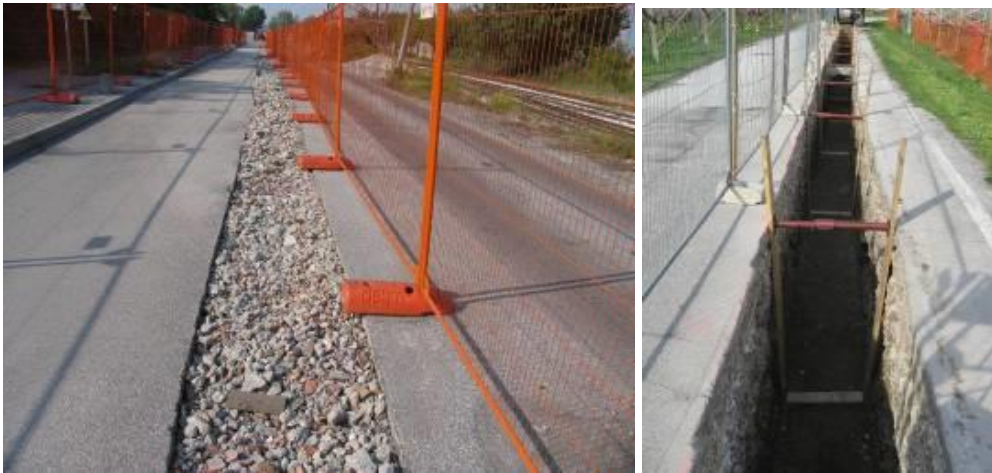
Taglio dell'asfaltatura e scavo aperto
