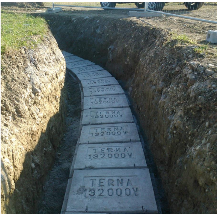
Rinterro con posa delle piastre di protezione e rete in PVC
