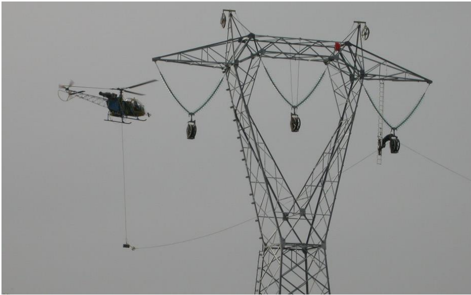
Figura 4.3.1 – fase di stendimento della corda pilota con l'ausilio dell'elicottero
