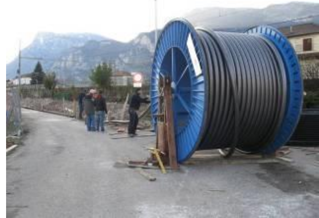
Posa rulli lungo lo scavo e stendimento del cavo
