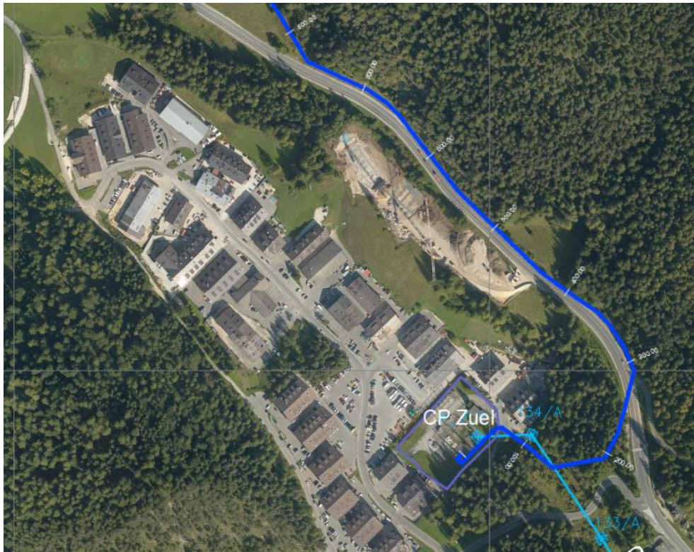
Foto 1 – CP Zuel e primo tratto del cavidotto, area artigianale di Cortina in località Pian da Lago
