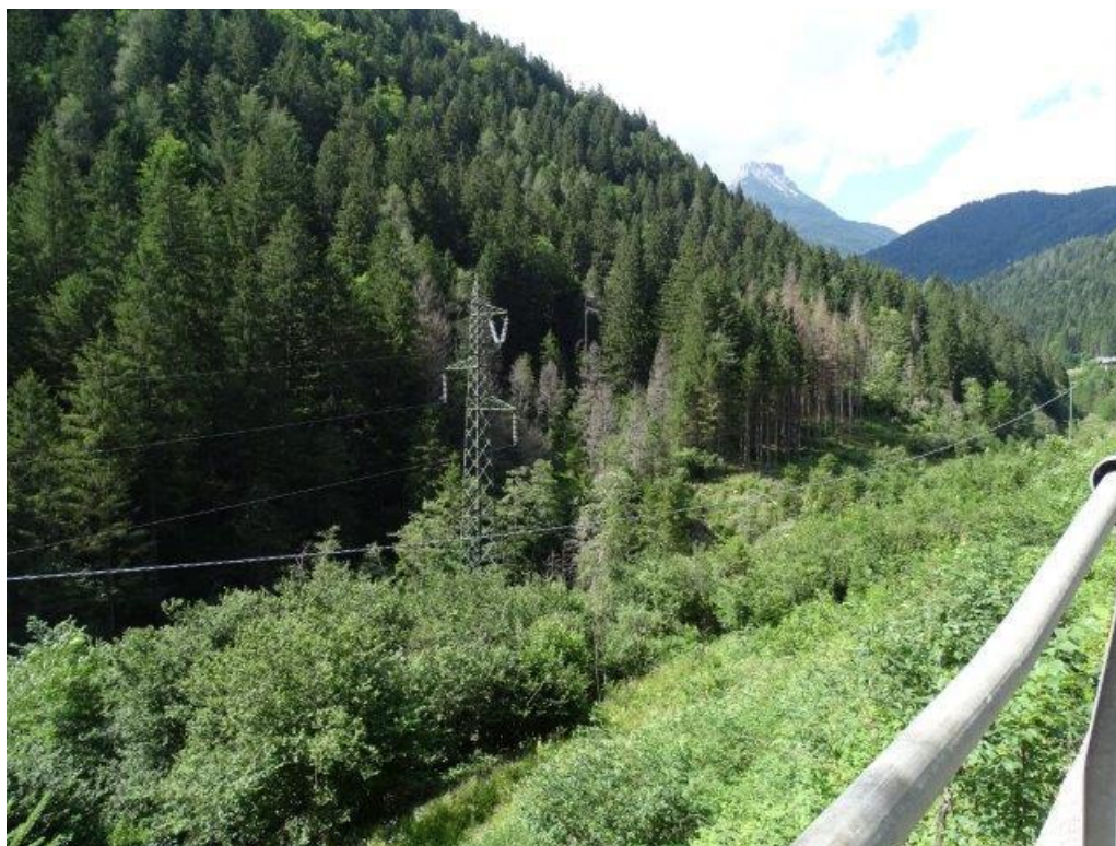
Foto 16 – Linea aerea 132 kV esistente dalla SS52 Carnica
