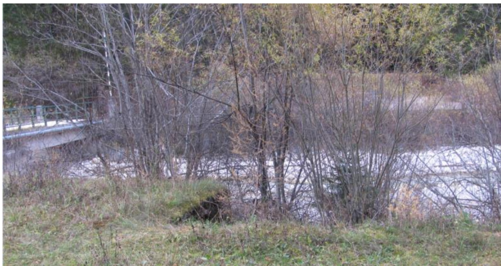
Foto 9 – Attraversamento del Fiume Ansiei
