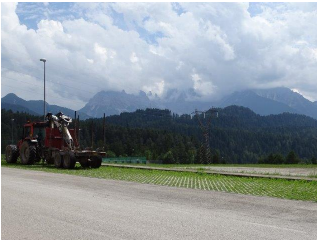
Foto 14 – Località Cima Gogna: Linea esistente a 220kV e sostegno della linea esistente 220kV da demolire
