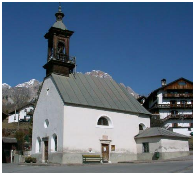
Figura 3.2.29 - Chiesa di Santa Giuliana
