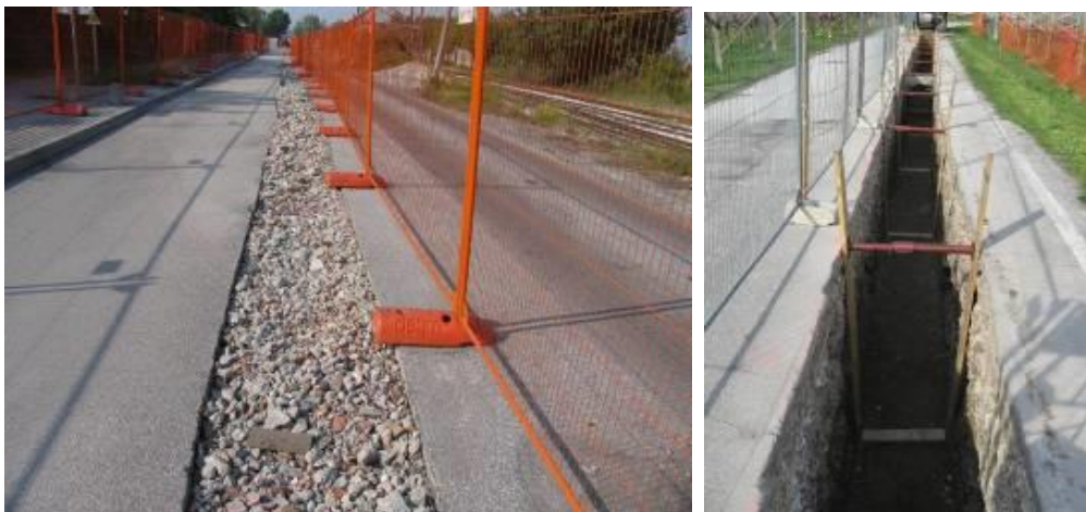
Taglio dell'asfaltatura e scavo aperto
