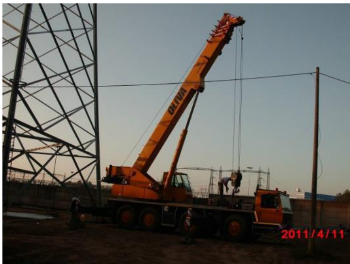
Fasi di montaggio sostegno a traliccio
