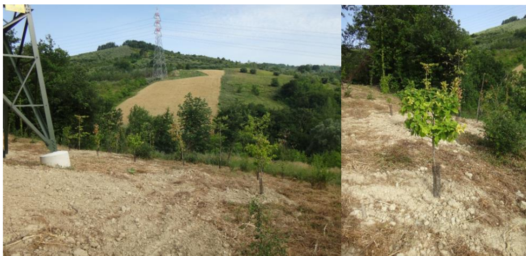
Esempio di ripristino di un microcantiere localizzato su un versante
