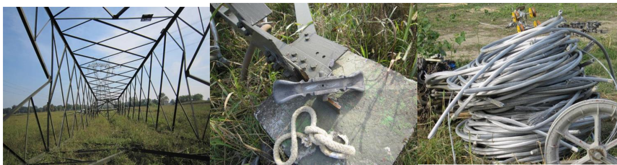
Fasi demolizione di un sostegno a traliccio
