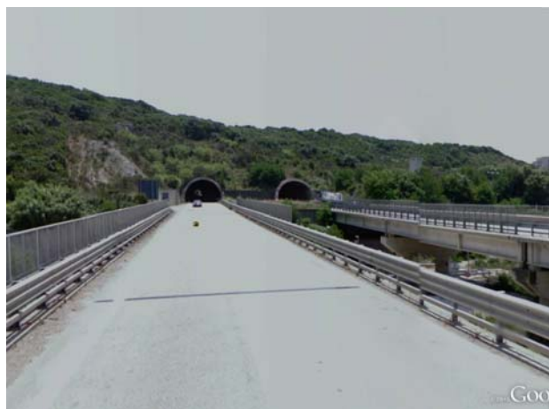
Figura 9: viadotto e galleria S.Carlo in prossimità di S.Vincenzo Nord
