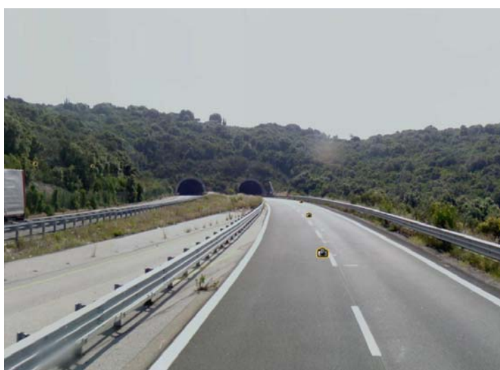
Figura 15: galleria Poggio Fornello
