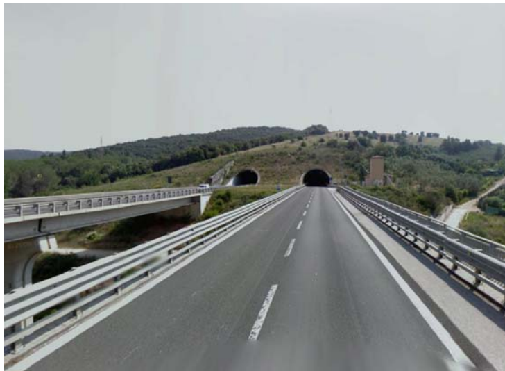
Figura 16: viadotto Val della Petraia e galleria Poggio Bastione
