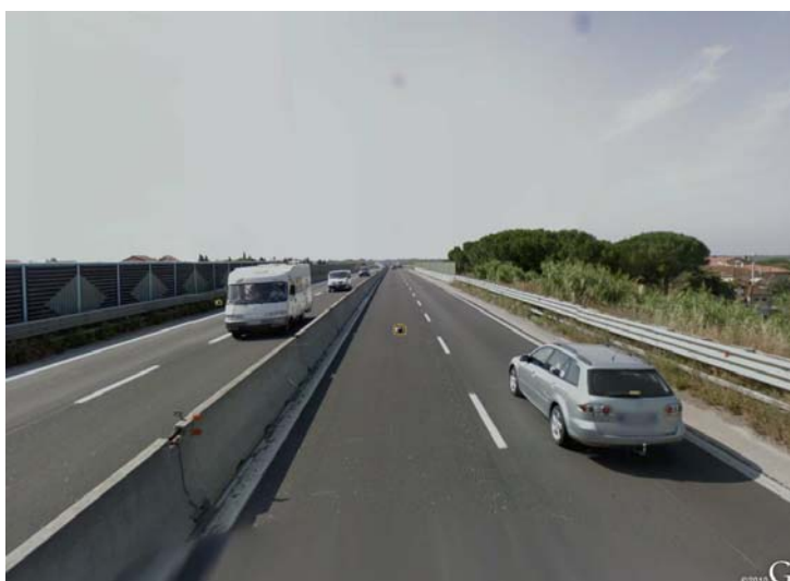
Figura 5: SS1 Aurelia in prossimità del viadotto Bibbona
