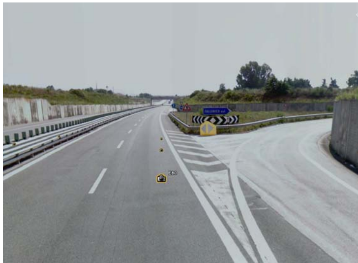
Figura 17: svincolo di Follonica Est
