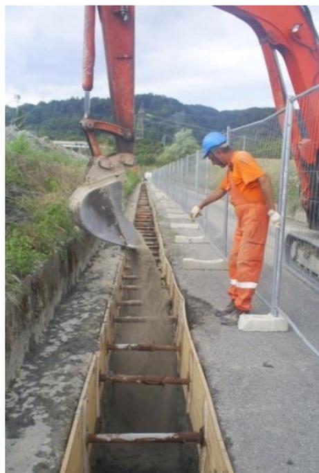
*Figura 4.8 - Taglio dell'asfaltatura e scavo aperto*
