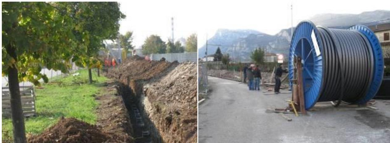
*Figura 4.11 - Fase di stendimento conduttore*
