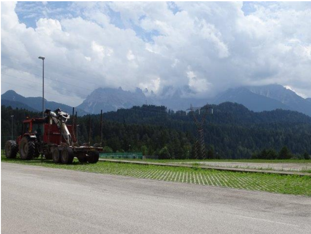
Foto 14 – Località Cima Gogna:Linea esistente a 220kV e sostegno della linea esistente 220kV da demolire
