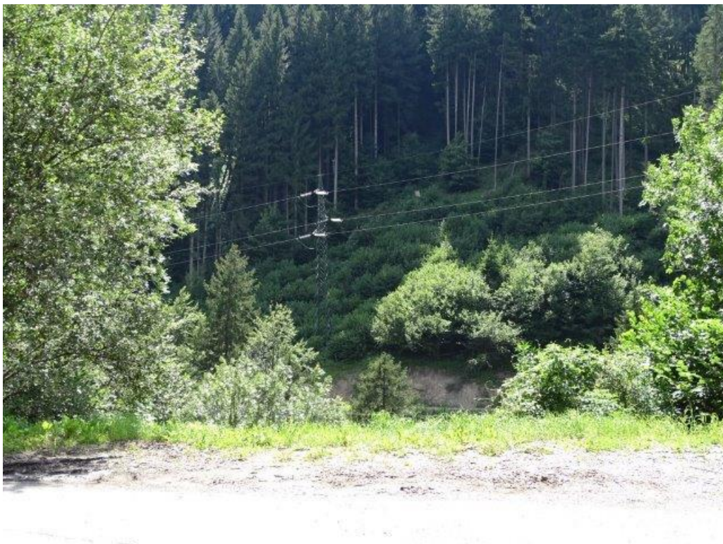
Foto 17 – Linea aerea 132 kV esistente dalla SS52 Carnica
