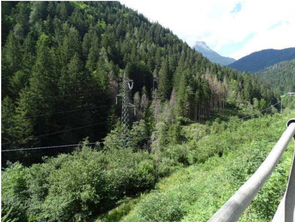
Foto 16 – Linea aerea 132 kV esistente dalla SS52 Carnica
