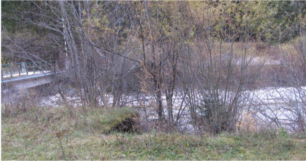
Foto 9 – Attraversamento del Fiume Ansiei
