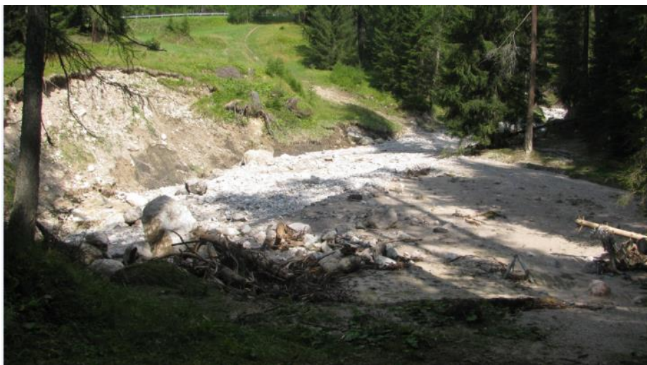
Foto 5 – Attraversamento Rio Bigontina (n.1)
