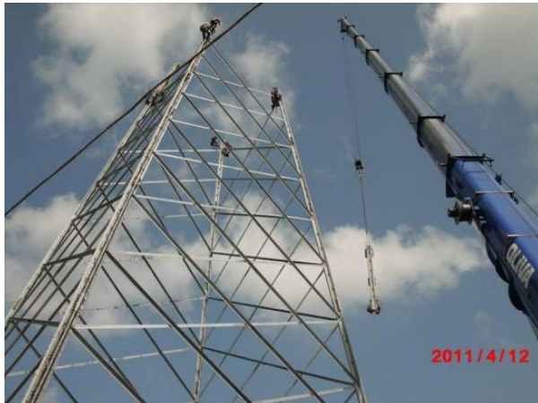
Fasi di montaggio sostegno a traliccio
