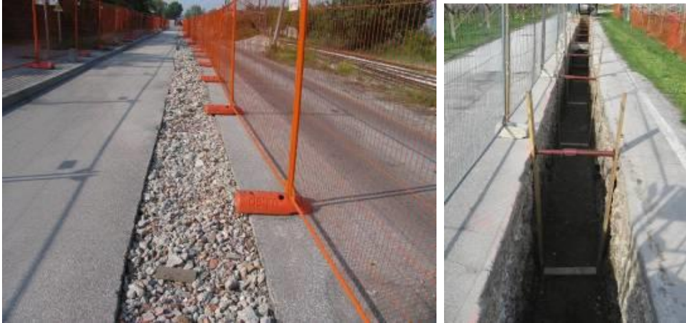
Taglio dell'asfaltatura e scavo aperto
