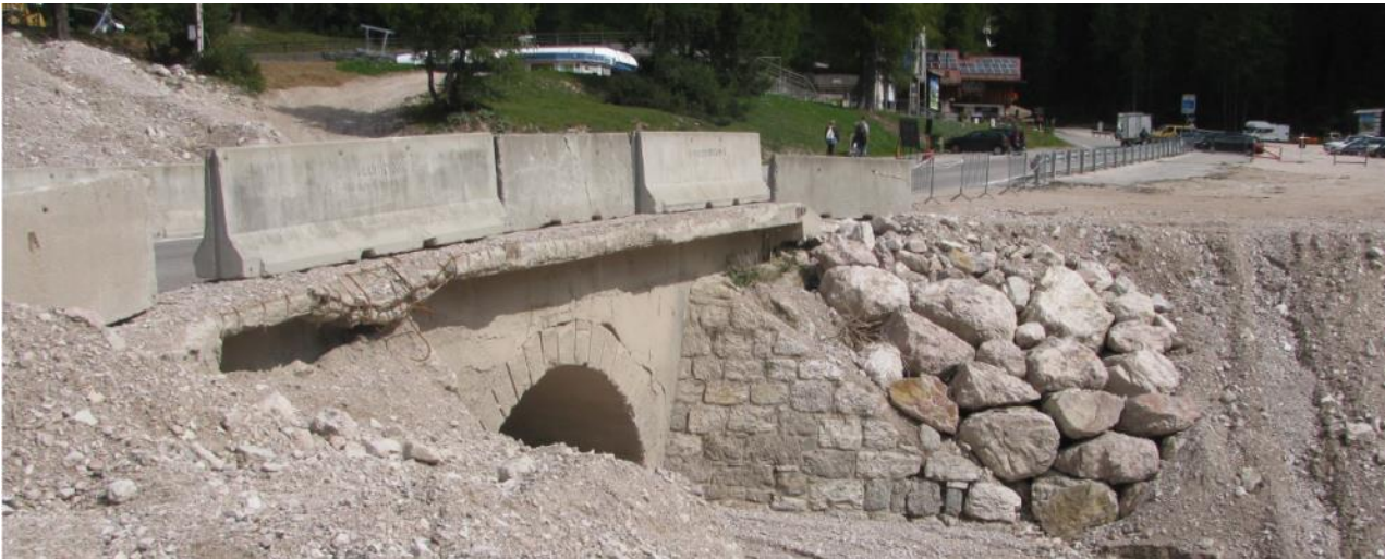
Foto 7 – Attraversamento Rio Bigontina (n.2)
