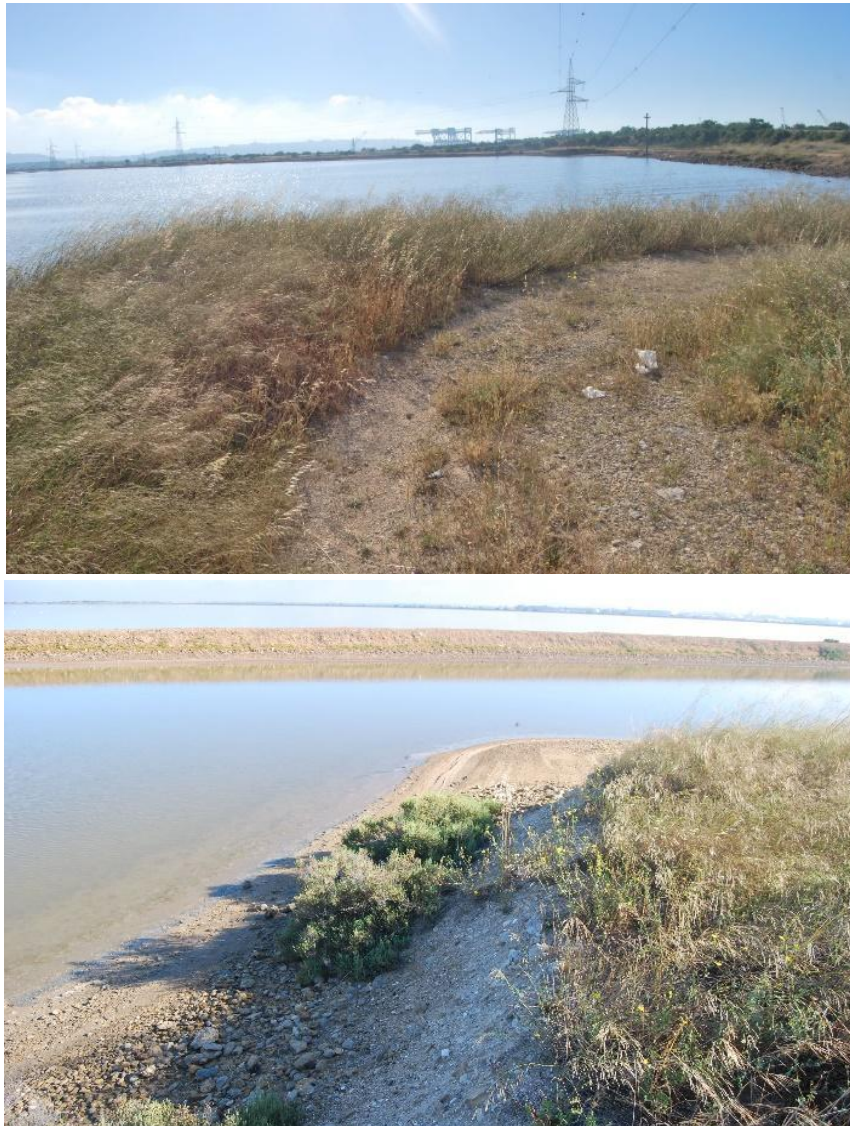
Vegetazione presente nella superficie sulla quale sono stati installati i tralicci dell'alta tensione nel settore critico delle saline di Macchiareddu
