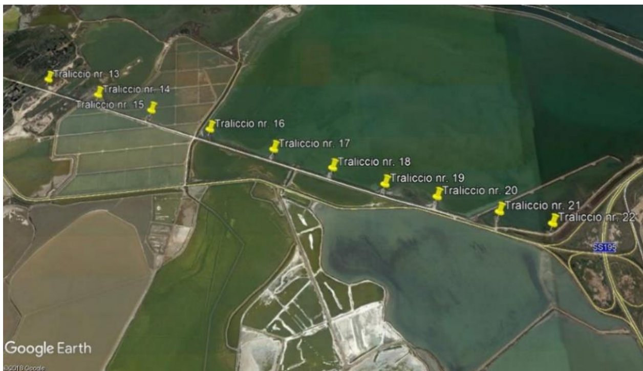
Numerazione dei tralicci assegnata dall'ENEL
