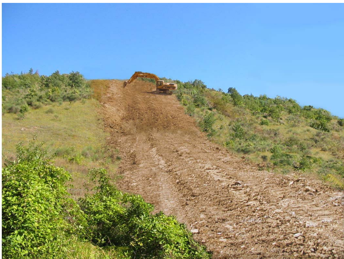
Fig. 4.4/O: Ridistribuzione dello strato di terreno vegetale
