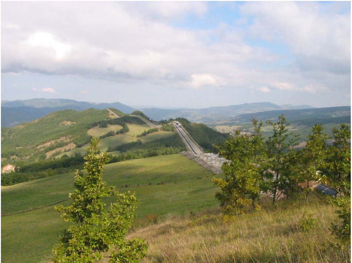
Fig. 4.4/C: Scavo della trincea e sfilamento delle tubazioni
