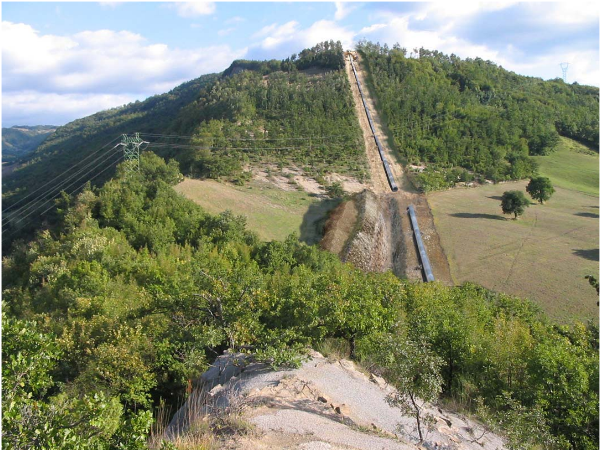
Fig. 4.4/H: Scavo della trincea e assiemaggio della condotta
