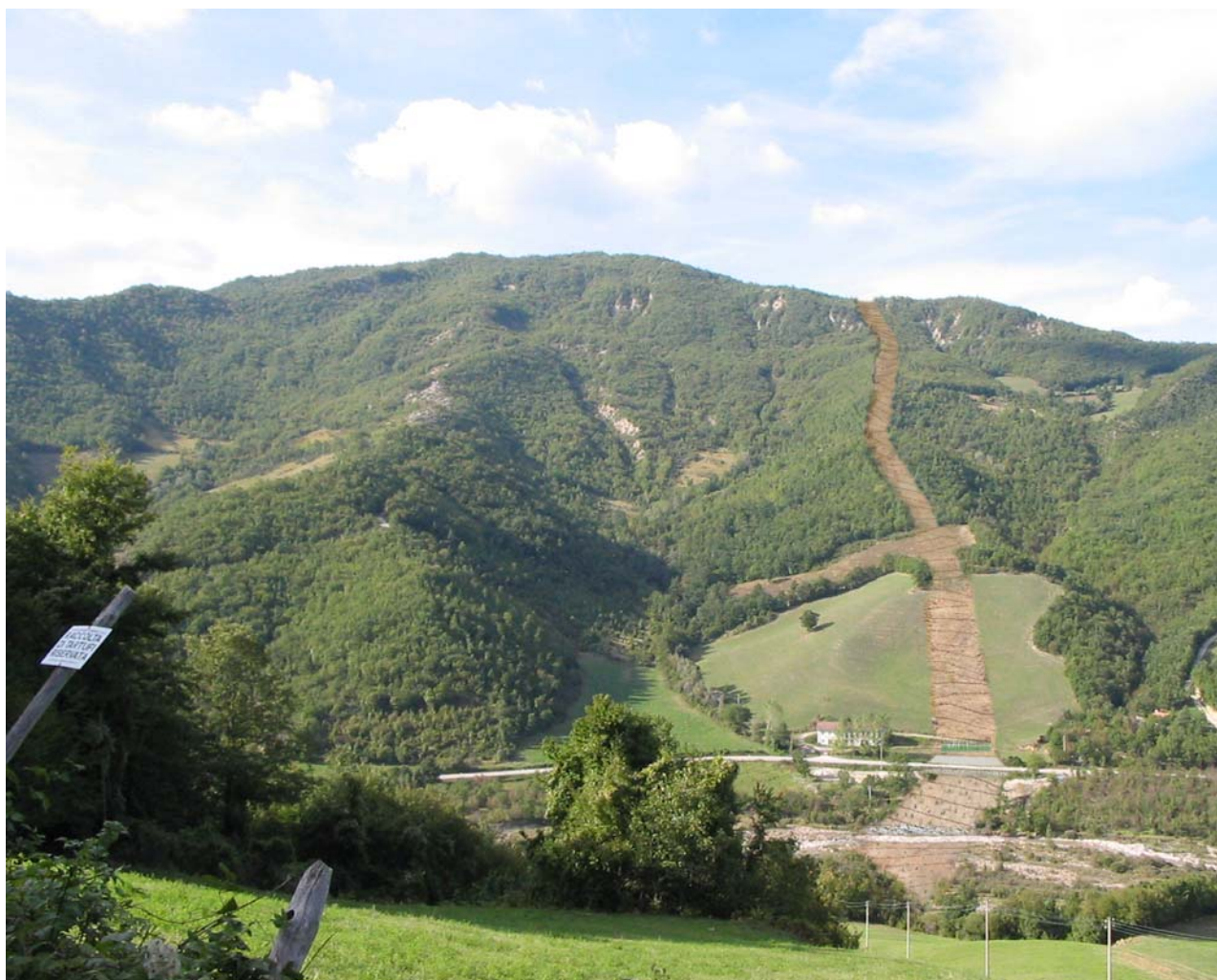
Fig. 4.4/U: Impianto di intercettazione di linea (PIL), realizzato in adiacenza alla sede stradale e ripristini geomorfologici
