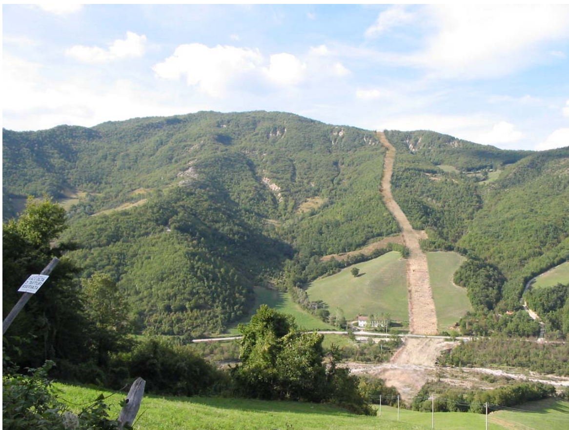
Fig. 4.4/S: Apertura dell'area di passaggio
