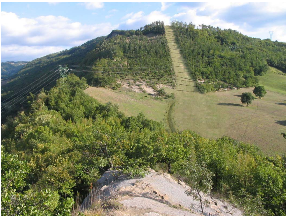
Fig. 4.4/J: Ripristini di linea ed inerbimento
