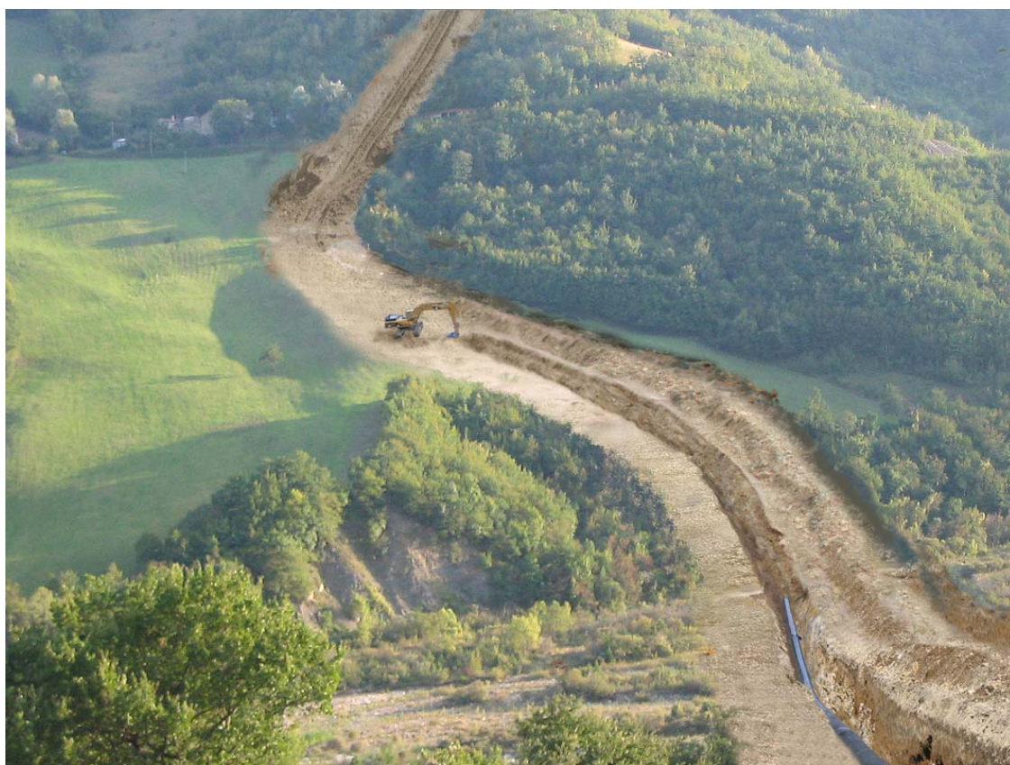
Fig. 4.4/AA: Scavo della trincea
