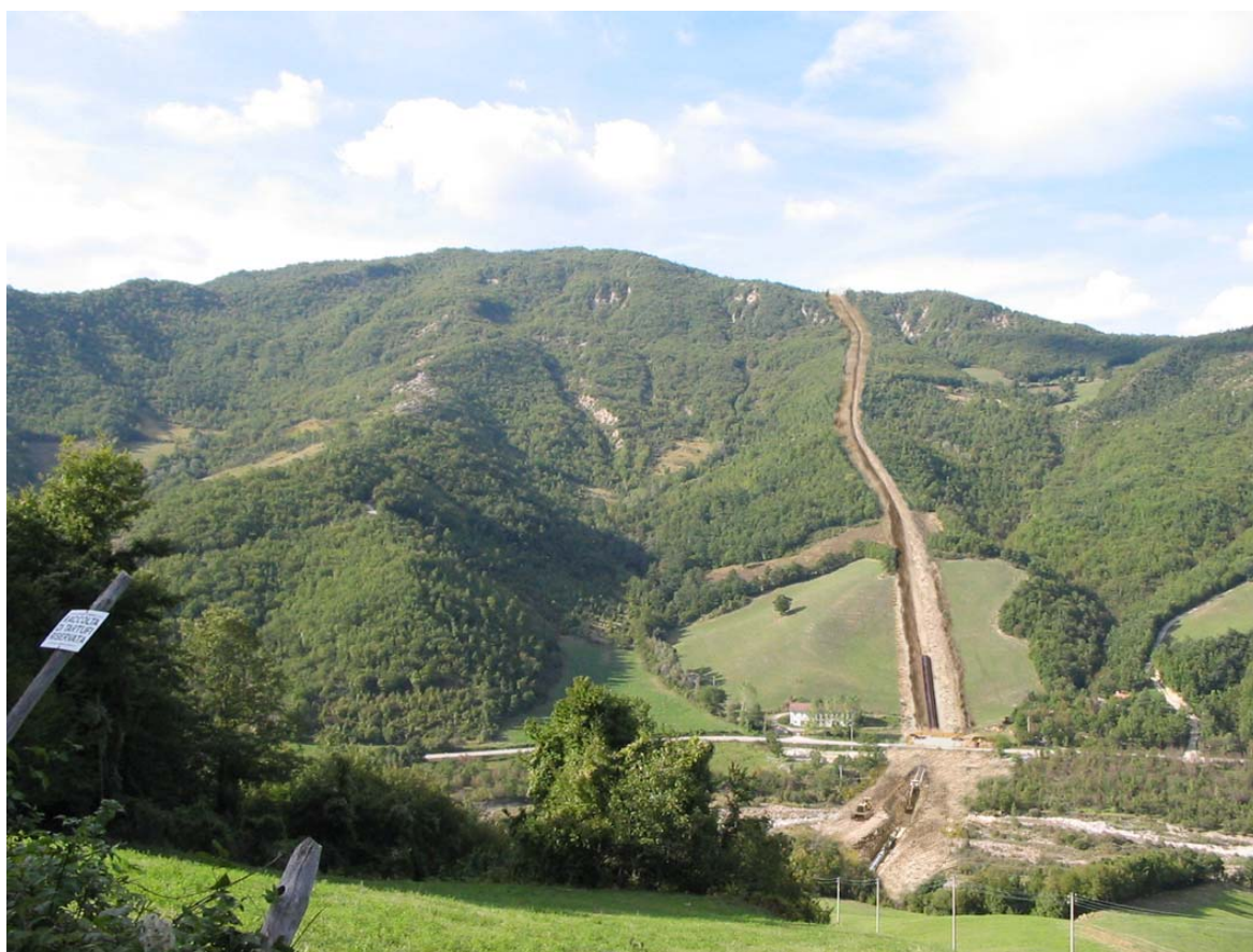
Fig. 4.4/T: Scavo della trincea e posa della condotta
