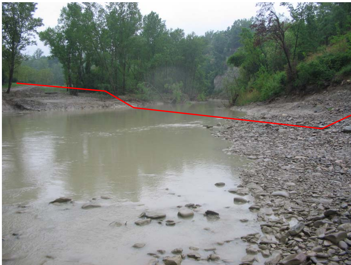
Foto 4.11/H: Nono attraversamento del F. Savio, poco a nord dello svincolo di Mercato Saraceno della superstrada E.45
