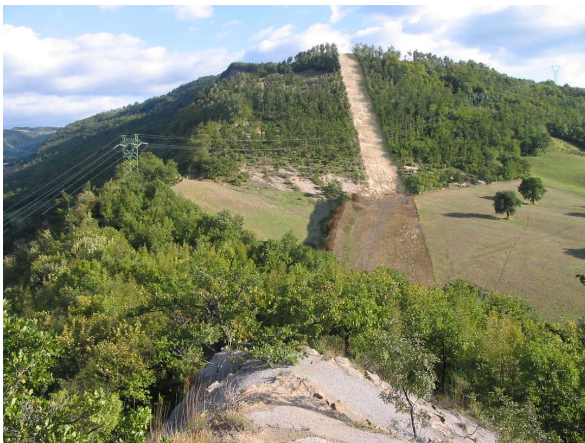
Fig. 4.4/G: Apertura dell'area di passaggio
