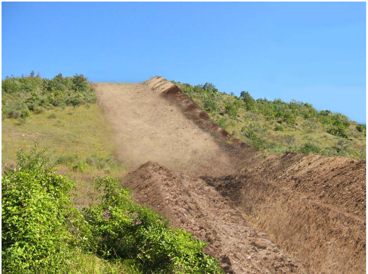
Fig. 4.4/M: Apertura dell'area di passaggio e scavo della trincea
