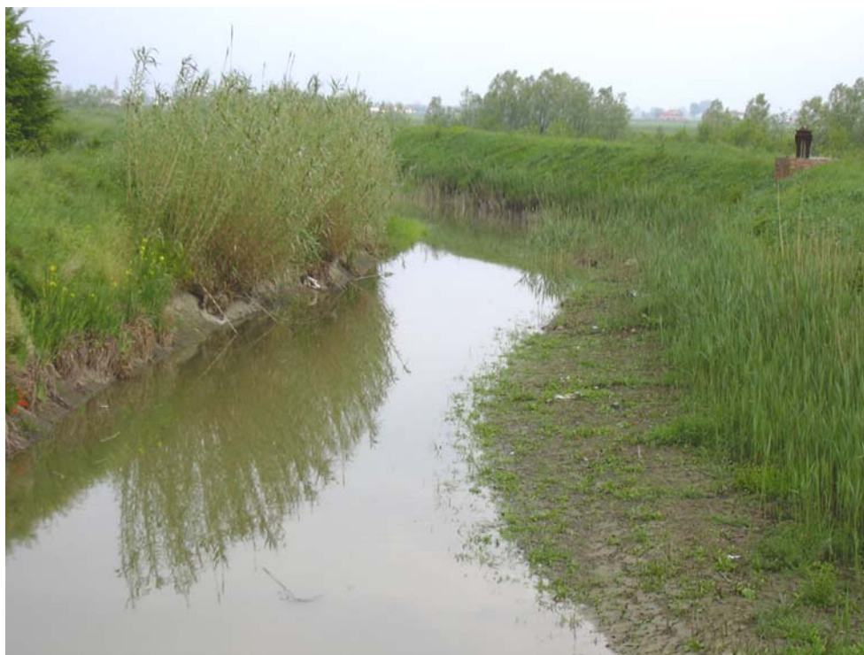
Foto 4.7/C: Canneto in corrispondenza di un canale secondario
