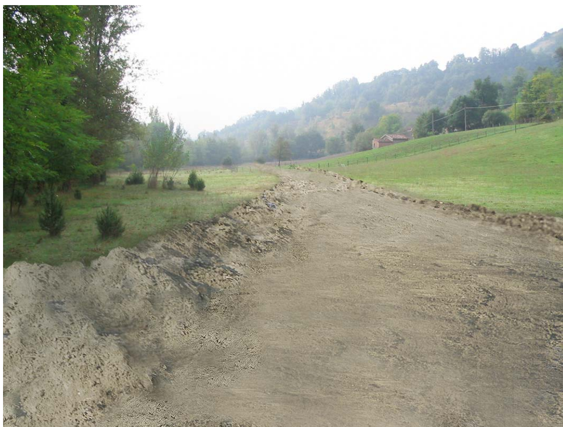
Fig. 4.4/AE: Accantonamento del terreno vegetale
