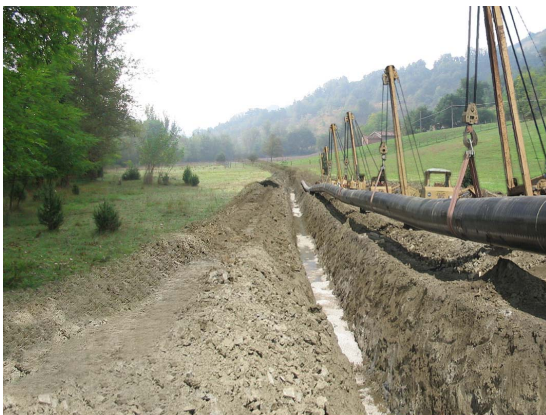
Fig. 4.4/AF: Posa della condotta
