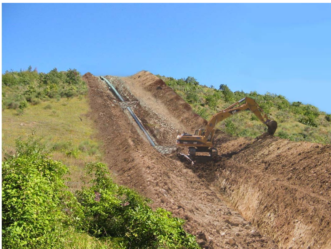
Fig. 4.4/N: Ritombamento della trincea
