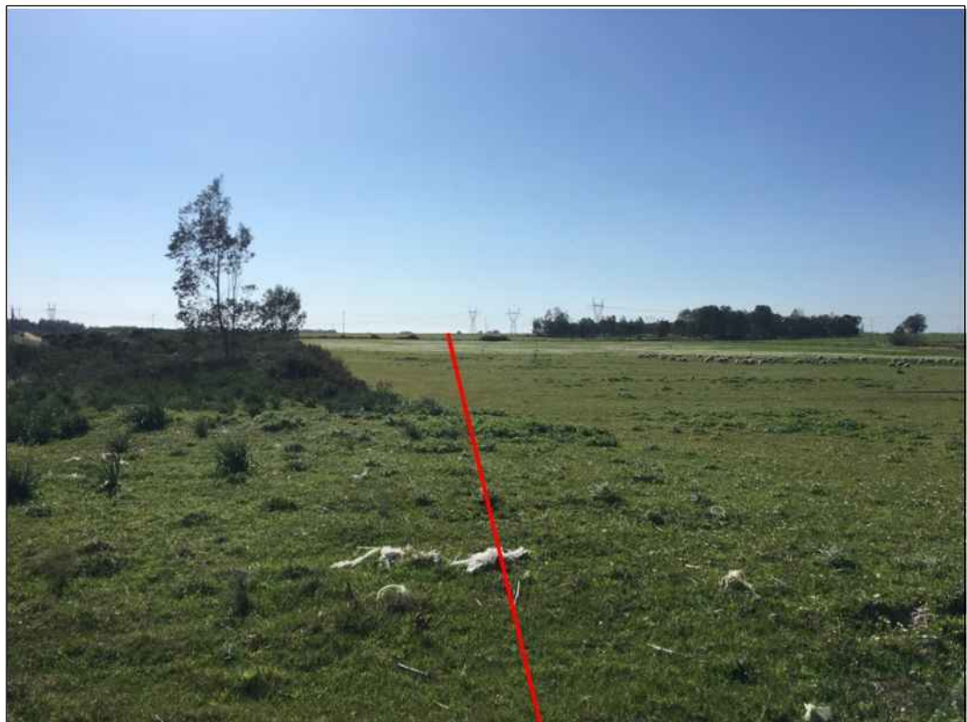
Percorrenza della condotta in terreni destinati al pascolo in prossimita' del Canale Adduttore Tirso Arborea, in Comune di Palmas Arborea
