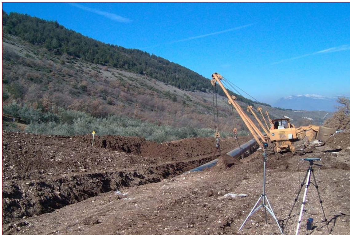
Fig. 4.2/A: Rilievi acustici durante l'operazione di posa della condotta in un cantiere analogo a quello oggetto di studio
