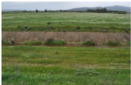
Panoramica Veduta da E verso O km 0,500.
