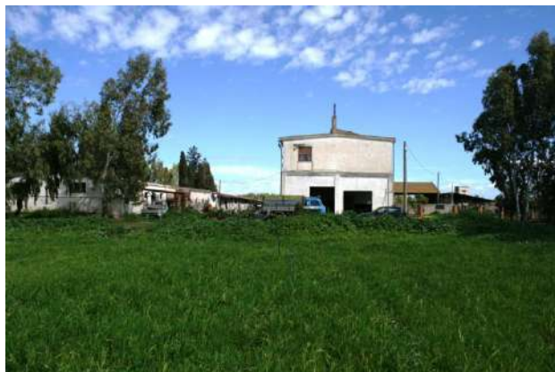
Panoramica Veduta da O verso E
