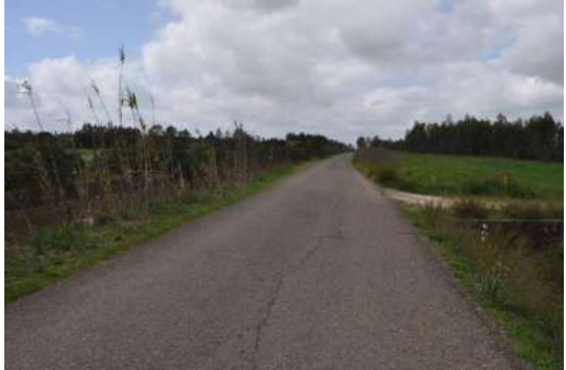
Panoramica Veduta da E verso O km 53,000.
