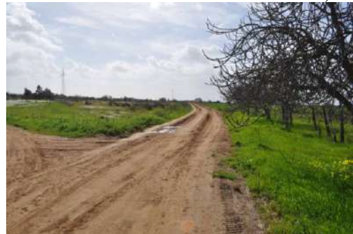
Panoramica Veduta da N verso S km 16.
