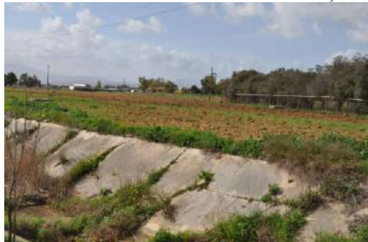
Panoramica Veduta da SO verso NE km 12,700.
