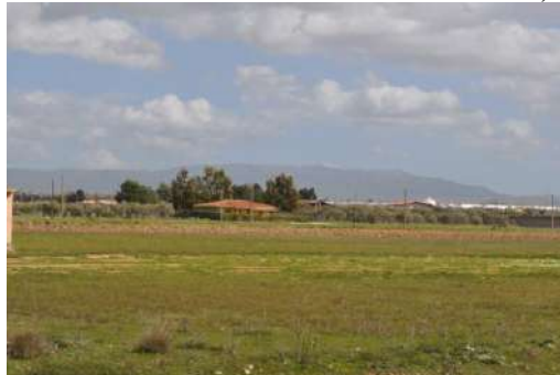
Panoramica Veduta da E verso O km 12,100.
