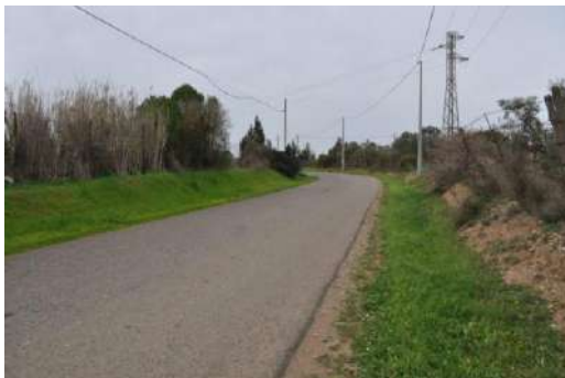
Panoramica Veduta da E verso O km 11,300.
