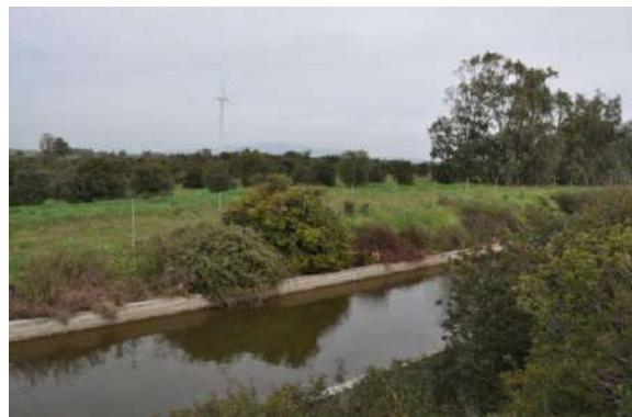
Panoramica Veduta da SO verso NE km 6,00.
