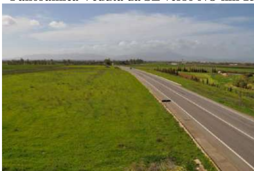
Panoramica Veduta da E verso O km 15,200.
