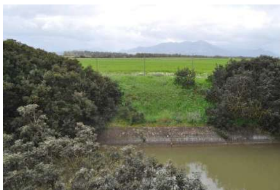
Panoramica Veduta da O verso E km 2,00.
