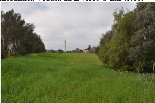
Panoramica Veduta da E verso O km 4,200.
