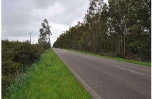
Panoramica Veduta da E verso O km 58,730.
