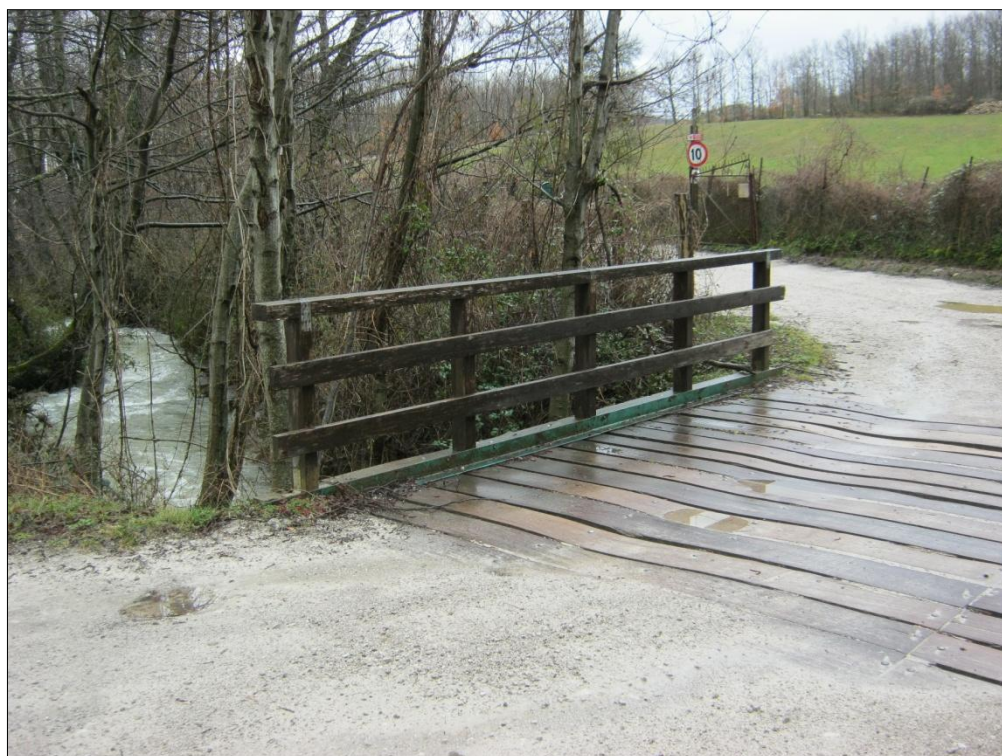
Figura 2.3: Ponte esistente per l'attraversamento del Torrente "La Terra".
