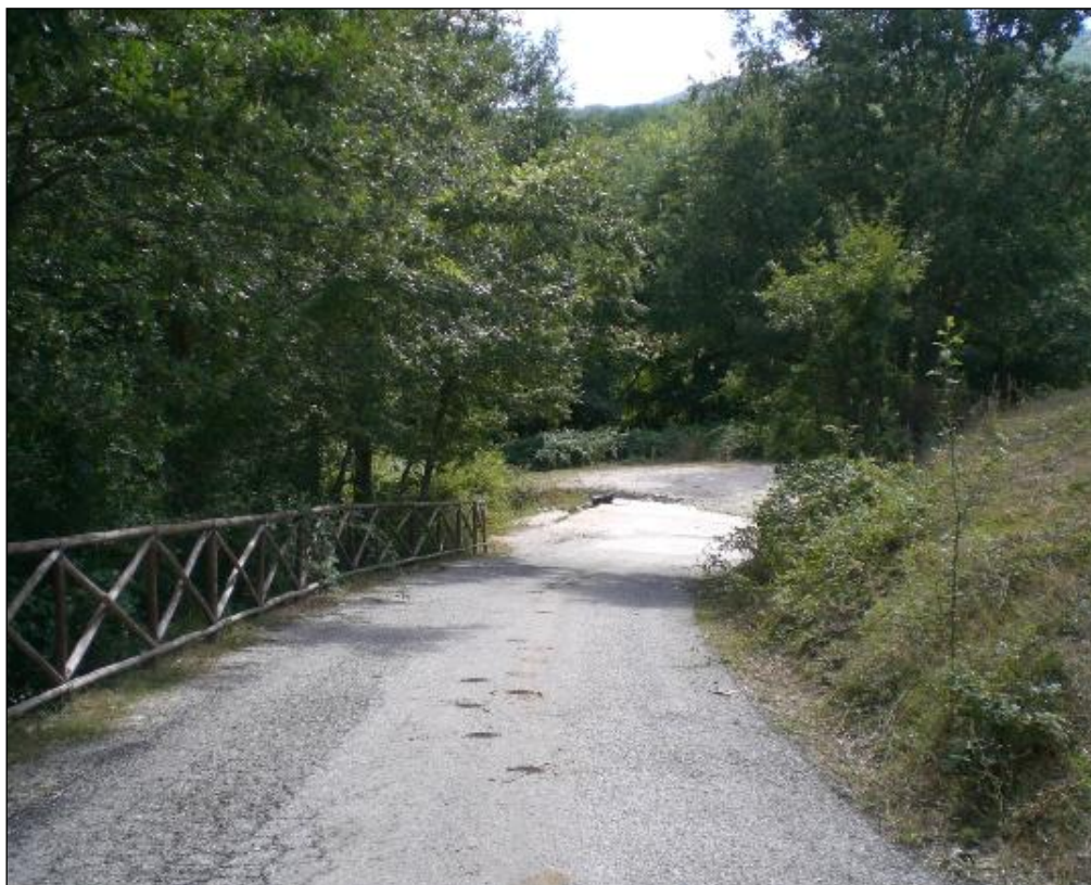
Figura 2.2: Strada di accesso al sito – lato Sud-Ovest.
