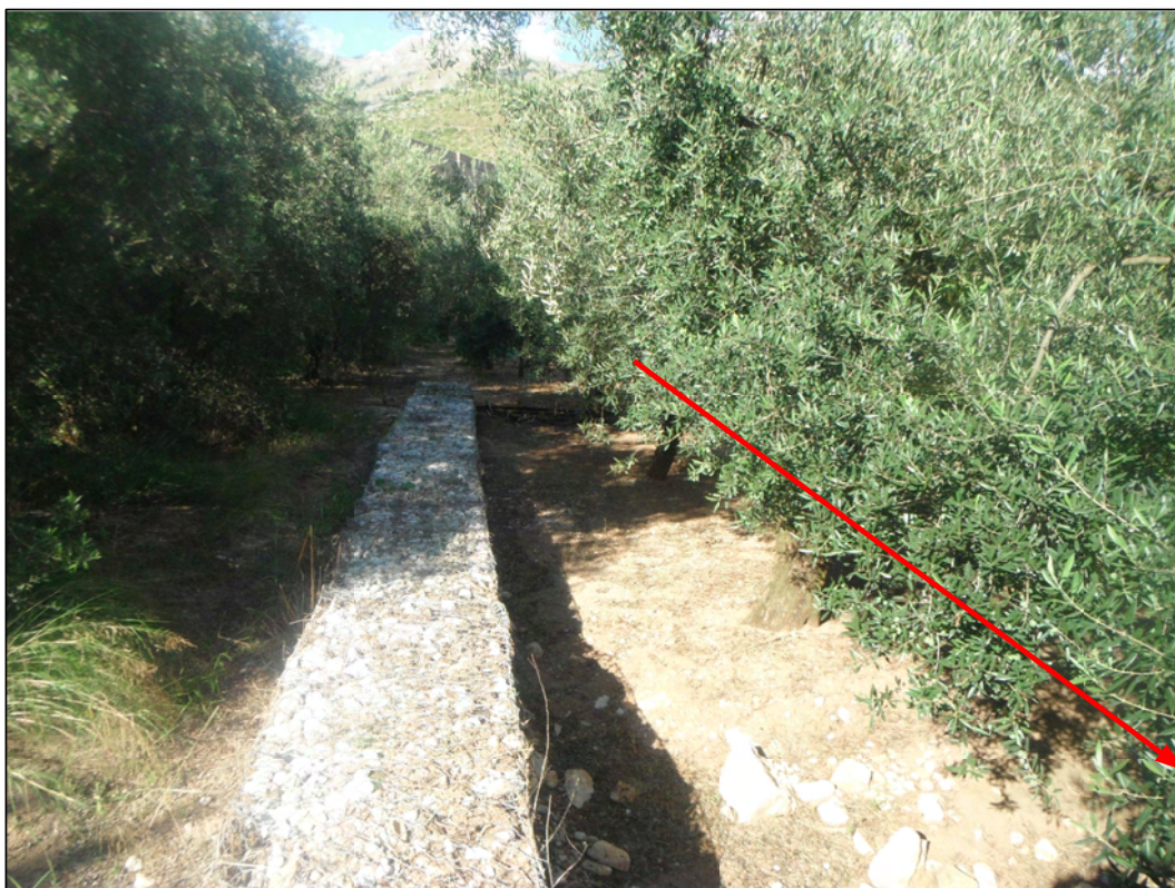
Percorrenza uliveto in prossimita' di gabbionata
