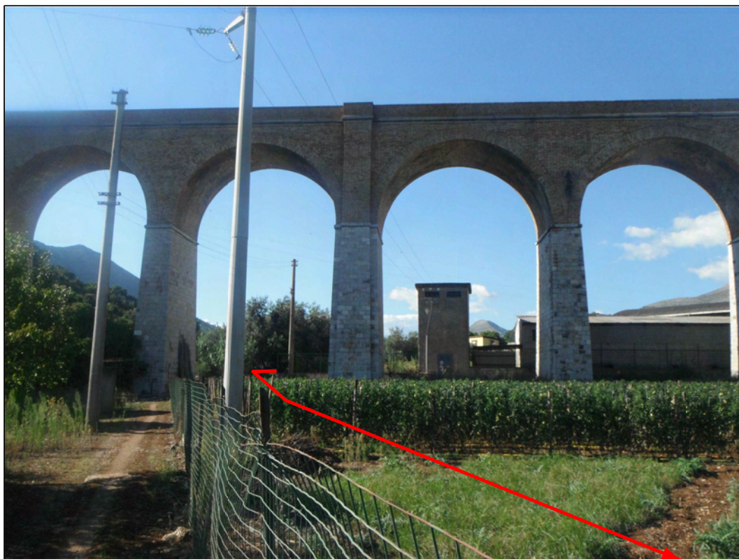
Attraversamento ferrovia Roma - Gaeta
