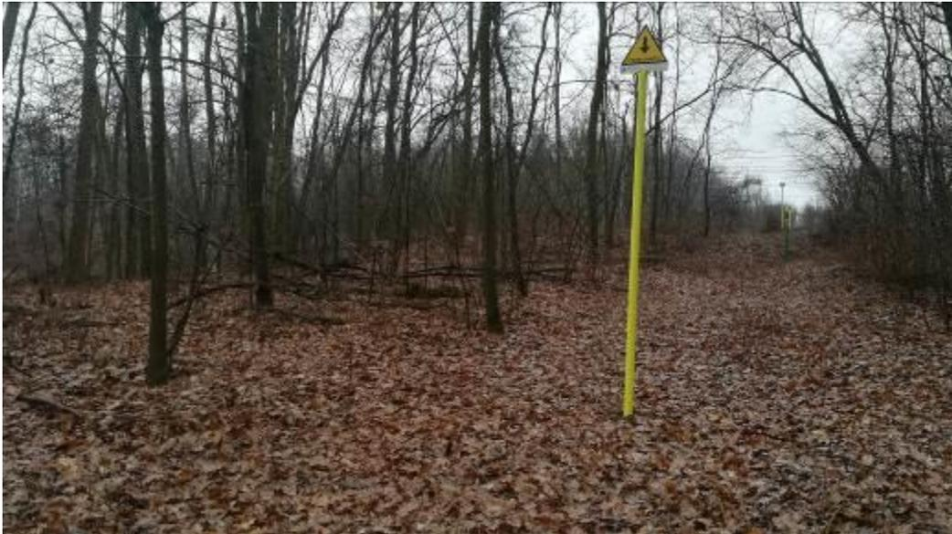
**Fig.12.5/C** – Formazione boscata presente sul tratto in dismissione che precede l'attraversamento della linea ferroviaria Torino – Genova. Si nota il corridoio libero a cavallo della tubazione.
