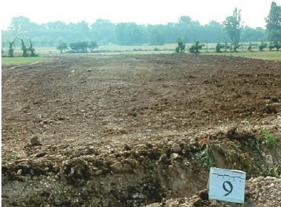
**Fig. 9.9/A** - Rinterro della condotta
