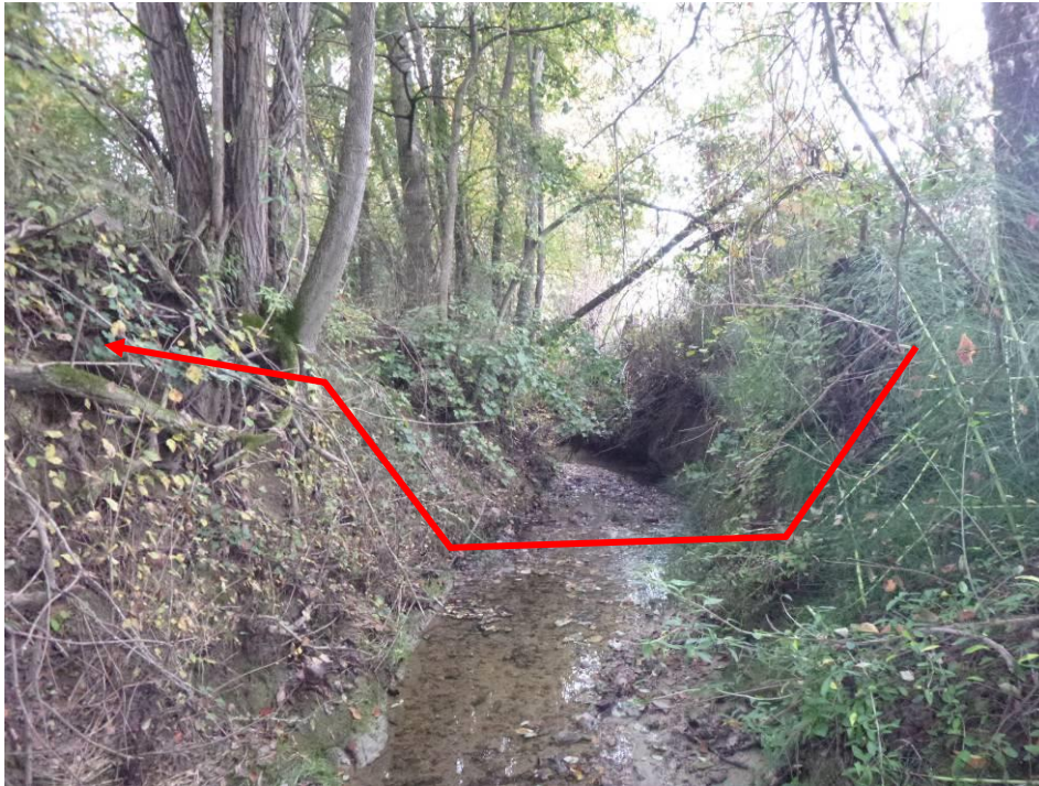
Foto n.9 – Attraversamento affluente del torrente Traversola (attraversamento a cielo aperto)
