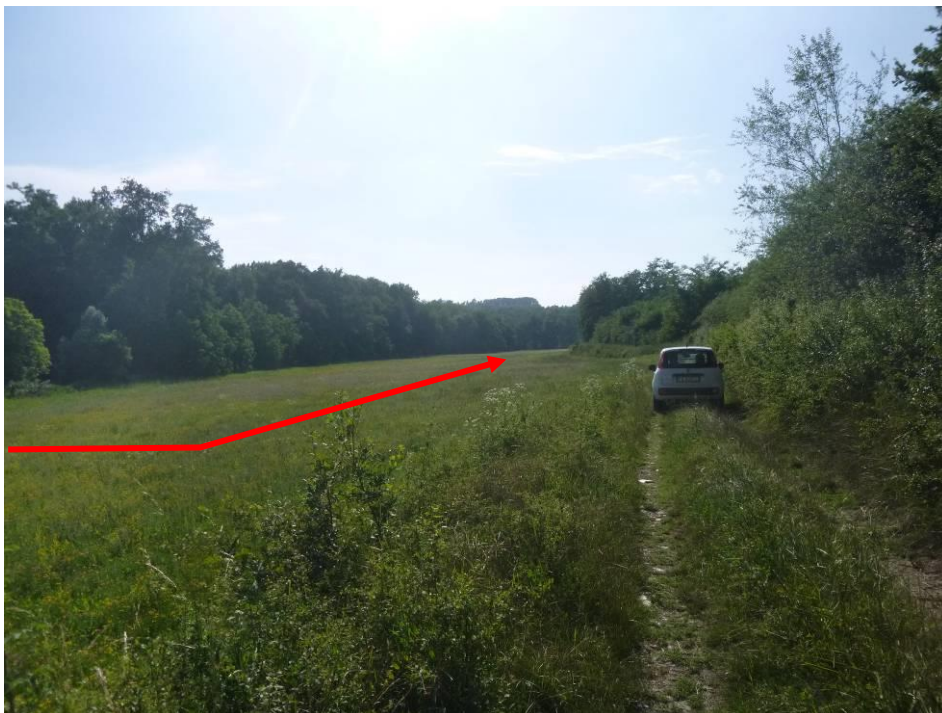
Foto n.16 – Panoramica percorrenza senso gas in parallelo ad una strada poderale.
