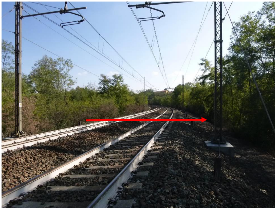
Foto n.24 – Attraversamento linea ferroviaria Torino – Genova con microtunnel
