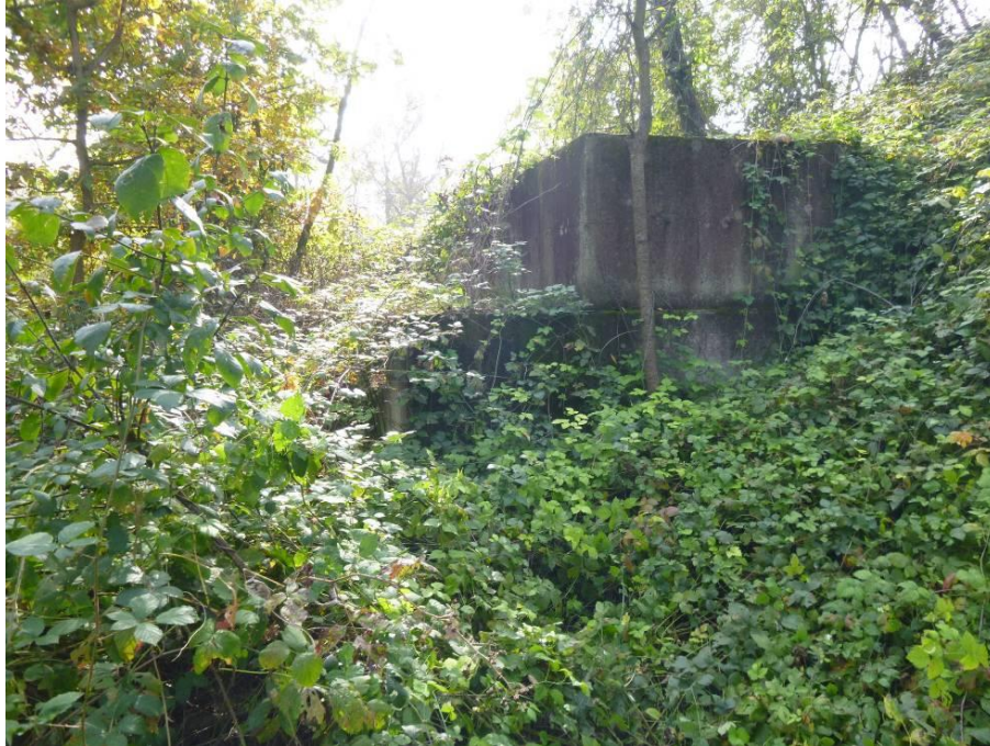
Foto n.23 – Particolare opera in CA di raccolta acque al piede del rilevato ferroviario (attraversamento in microtunnel)
