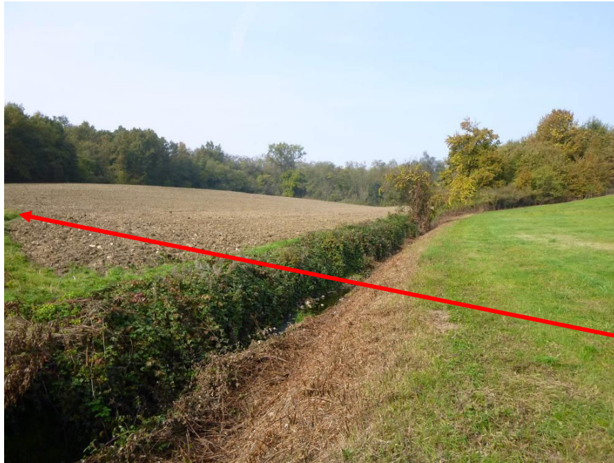
Foto n.19 – Attraversamento affluente del torrente Traversola (attraversamento a cielo aperto)
