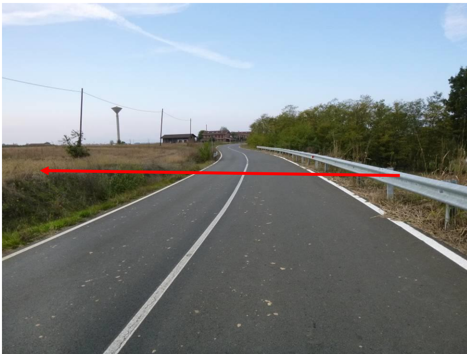
Foto n.34 – Attraversamento Strada Provinciale n.16 (con trivellazione spingitubo)
