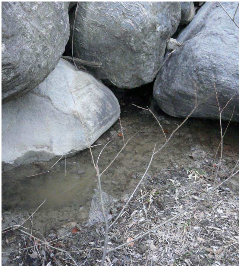
Figura 3-37: pozza in prossimità dell'alveo del T.Clarea, in continuità con l'alveo stesso. Marzo 2016
