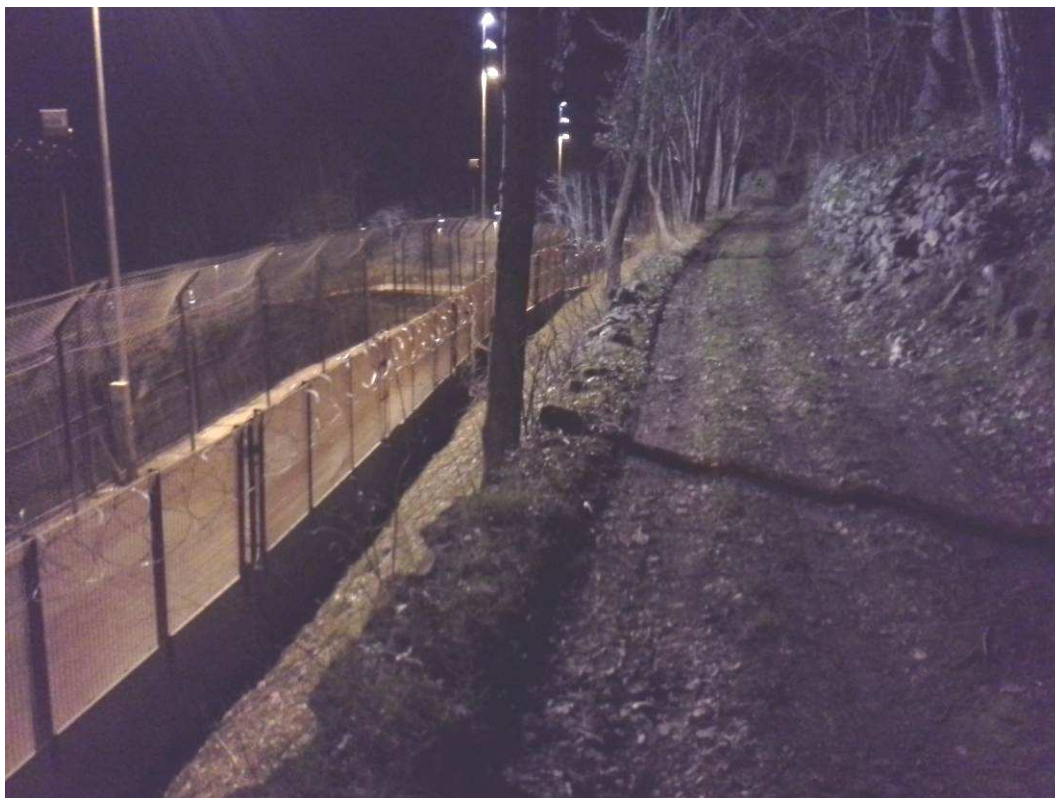
Figura 3-66: strada in prossimità delle recinzioni meridionali del cantiere, lungo il versante maggiormente idoneo a ospitare popolazioni di anfibi (primavera 2015).
