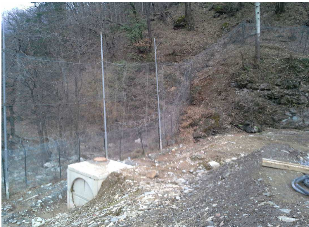
Figura 3-65: estremità est del cantiere, oltre il sottopassaggio, dove è stato rinvenuto un adulto di salamandra in primavera 2015.
