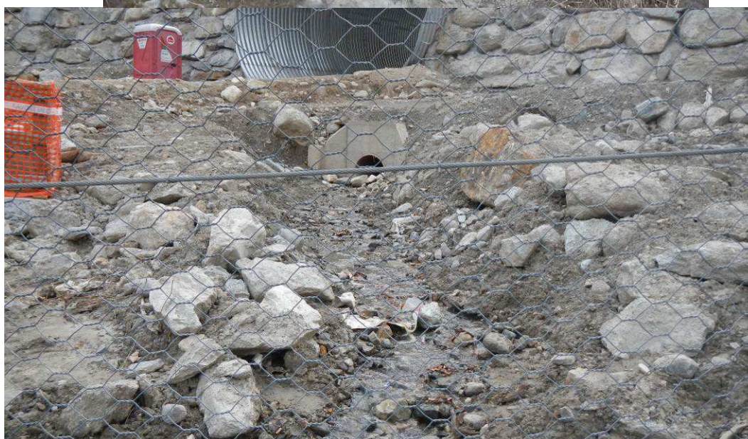
Figura 3-35: zona di uscita dell'impluvio dalla zona di cantiere- primavera 2014. Figura 3-36: zona di uscita dell'impluvio dalla zona di cantiere- primavera 2015.
