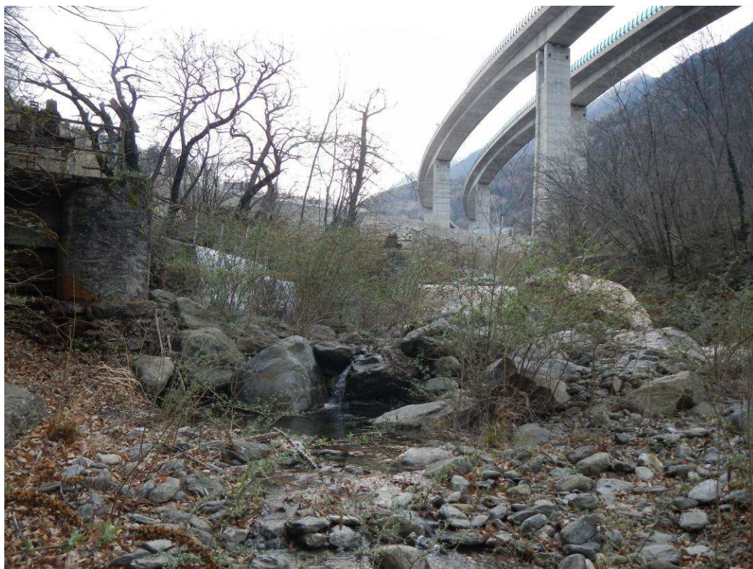
Figura 3-47: pozze d'acqua in corrispondenza del manufatto-primavera 2014.
