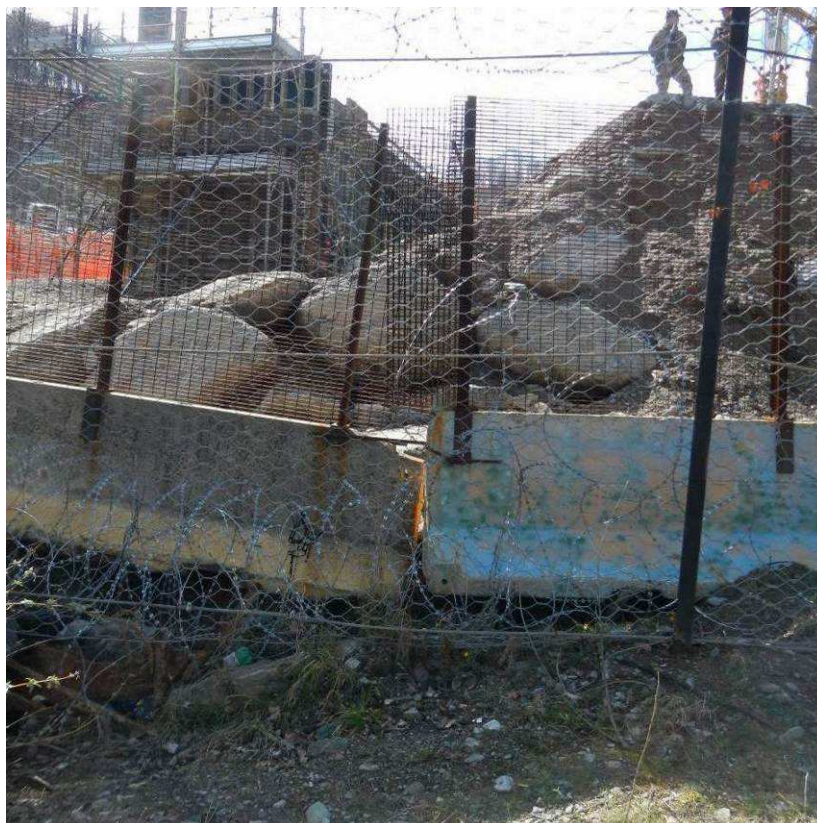
Figura 3-33: zona di uscita dell'impiuvio dalla zona di cantiere. Si nota il riporto di terra all'interno della zona di cantiere con completa copertura del piccolo corso d'acqua-primavera 2013.
