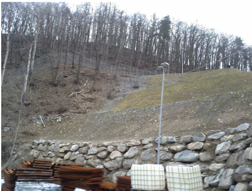
Figura 3-64: area meridionale del cantiere, oltre il sottopassaggio (primavera 2015).
