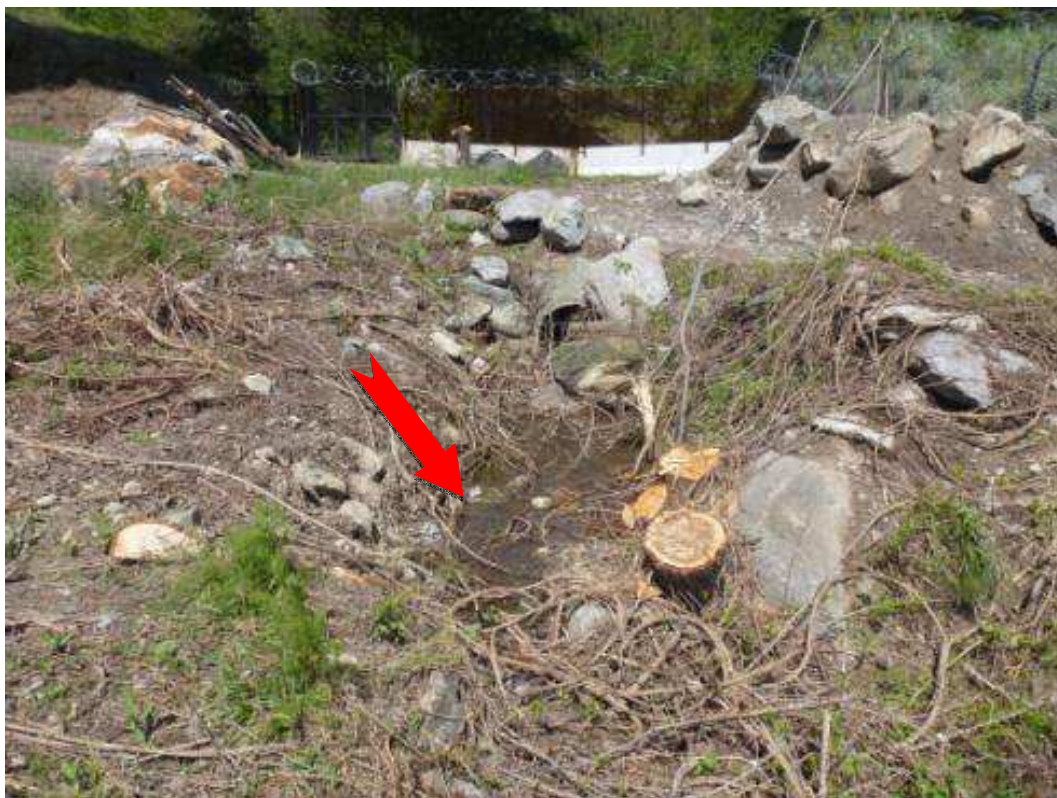
Figura 3-29: impluvio all'interno dell'area di cantiere in zona già soggetta a disboscamento e movimento terra-estate 2012.
