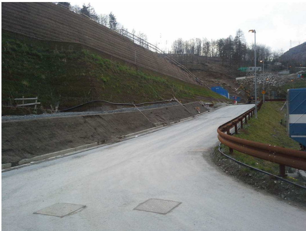
Figura 3-62: area di cantiere con versante avanzato dall'accumulo dello smarino (primavera 2015).
