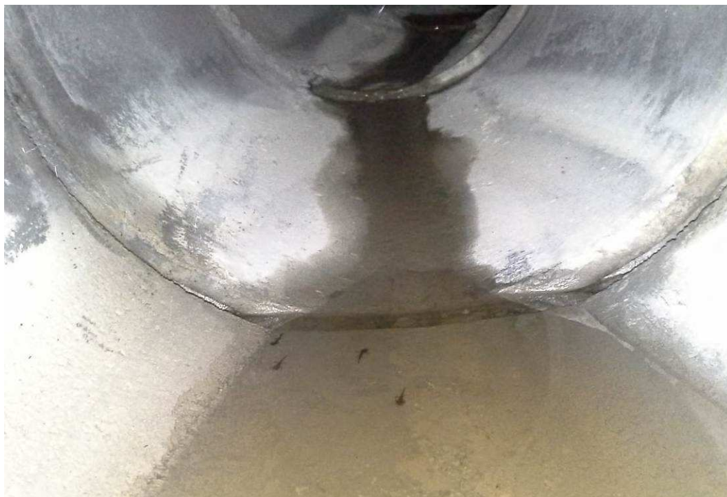
Figura 3-43: presenza di larve di salamandra pezzata all'interno della tubazione
