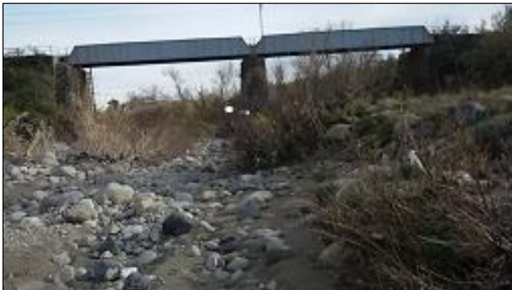
Figura 6 – Attraversamento ferroviario alla sezione 8 di rilievo.
