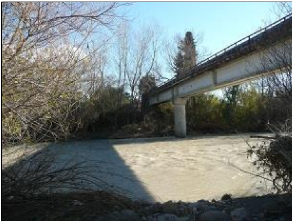
Figura 4 – Attraversamento aereo dell’acquedotto Fiumefreddo in gestione ad AMAM S.p.A., alla sezione 25 di rilievo.
