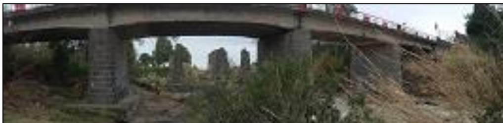
Figura 7 – Attraversamento della SS 114 alla sezione 7bis di rilievo.
