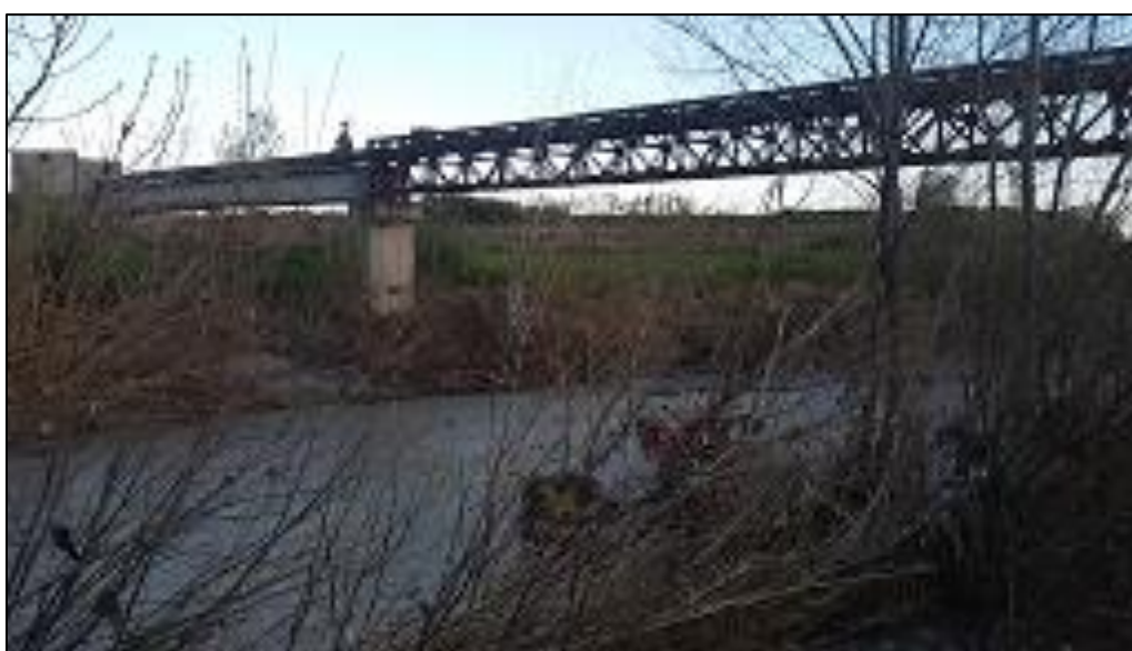
Figura 5 – Attraversamento aereo alla sezione 12 di rilievo.
