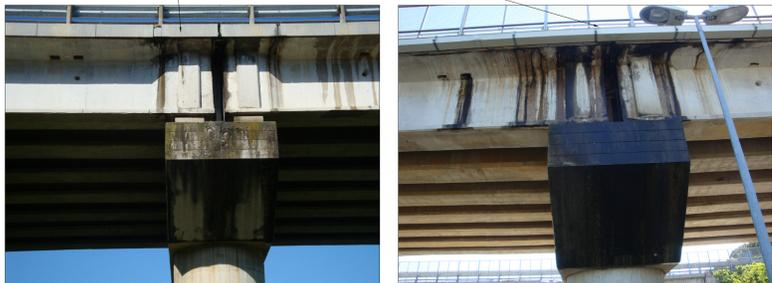
QUARTA FASE: RIMOZIONE E SOSTITUZIONE GIUNTO DI DILATAZIONE A TAMPONE
