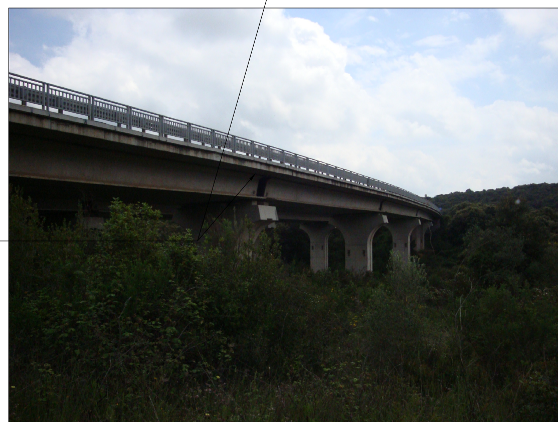
- Integrazione e sostituzione dei piluvini dove mancanti o rotti.
