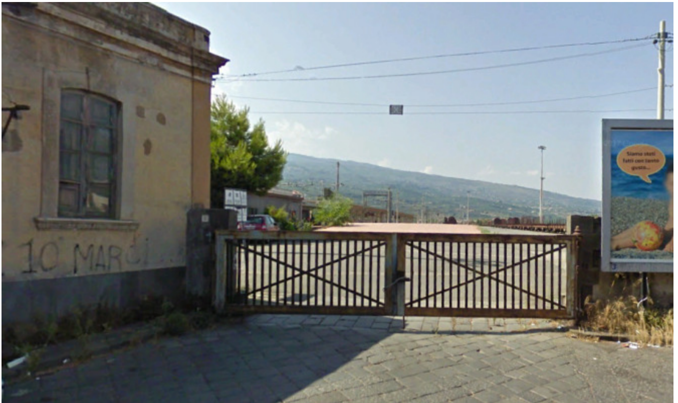
Foto 1 (vista eccesso di cantiere CA01.1 A)
