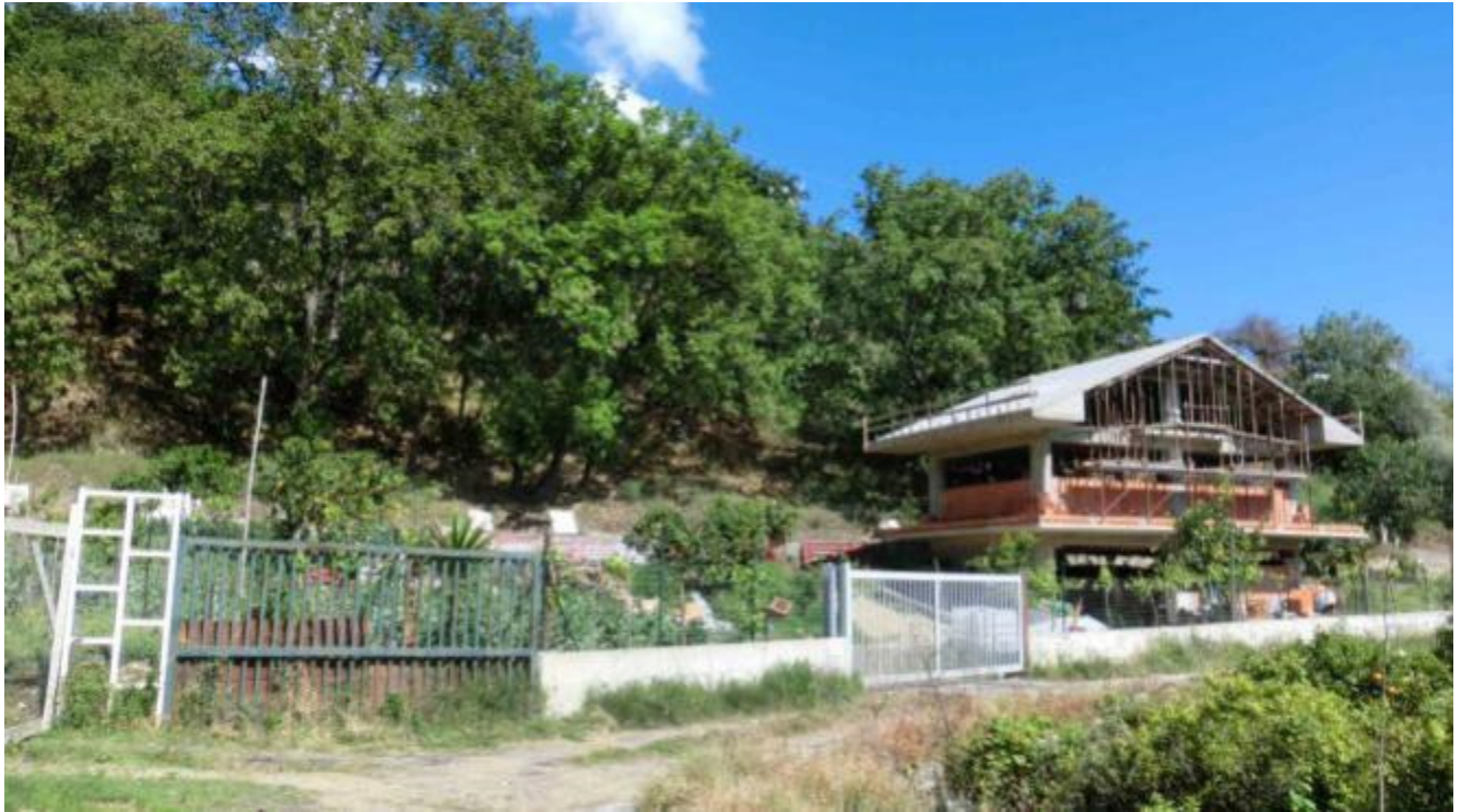
Foto 2 – Fabbricato esistente da demolire
