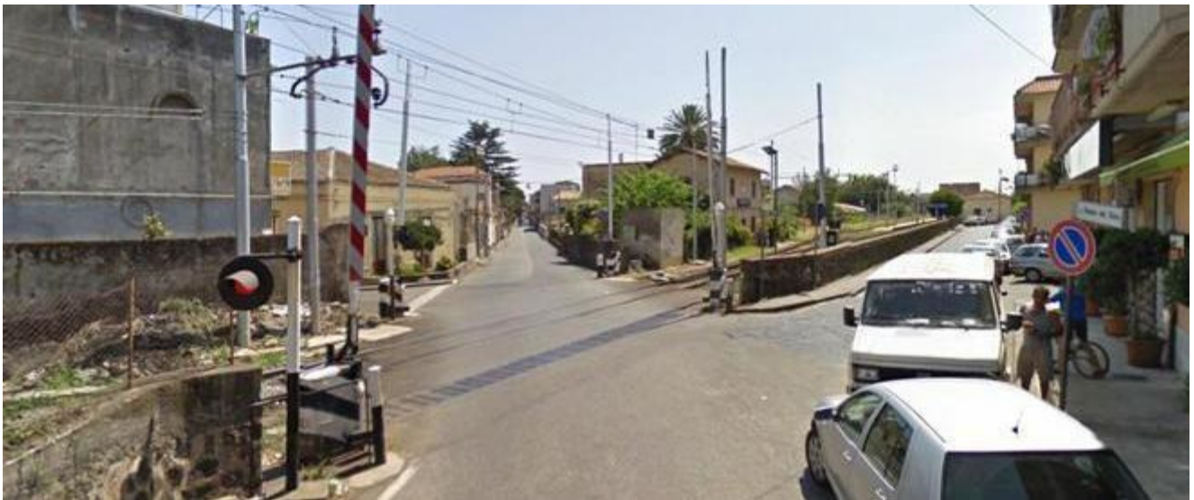
Passaggio a livello esistente
