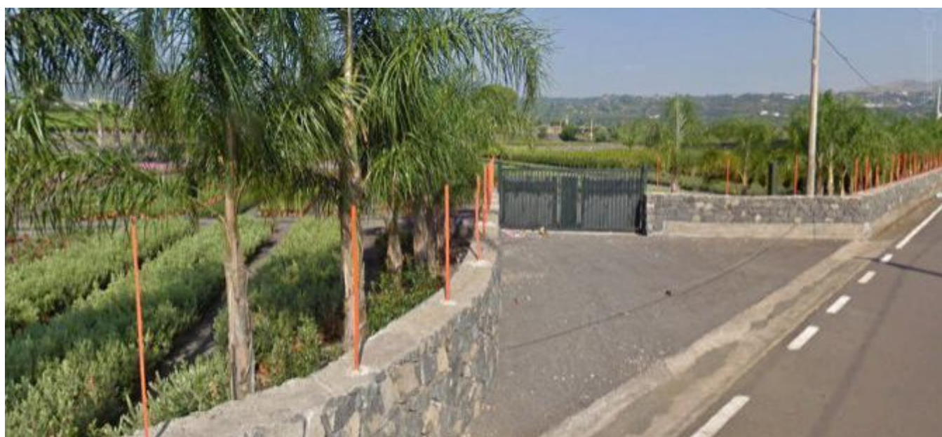
Foto 1 - Vista aeree di deposito DT01.1 e DT02.1
