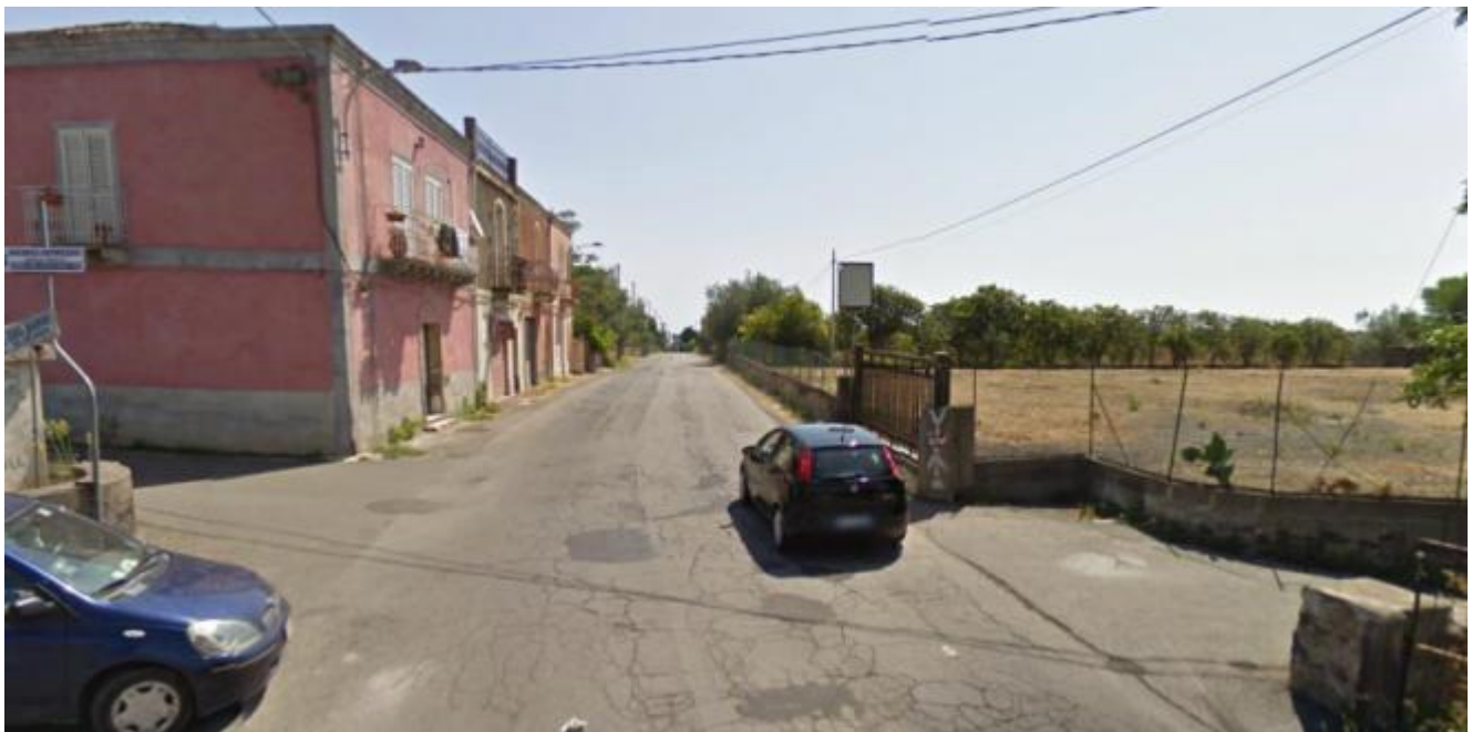
Foto 2 - vista area di cantiere dalla SP 186
