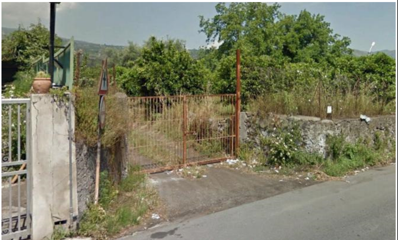
Foto 1 – Vista della pista attuale di accesso all'area dove realizzare la viabilità per la SSE
