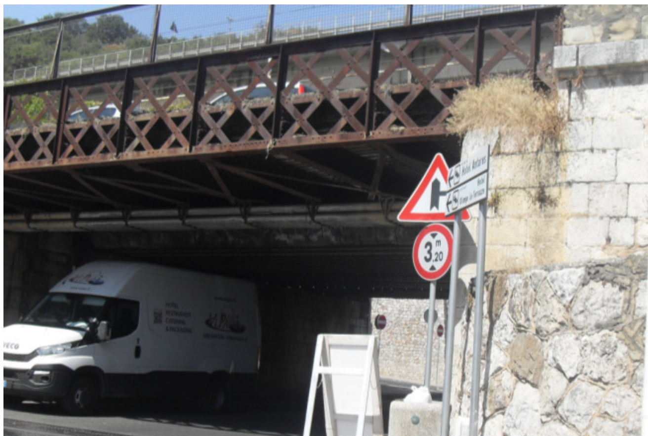
Vista aerea sottopasso stradale/ferroviario di accesso al lungomare di Mazzeo-Letojanni
