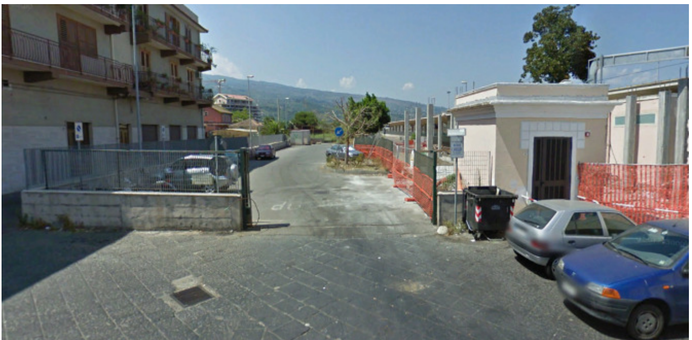
Foto 1 (vista eccesso di cantiere CA01.1 B)
