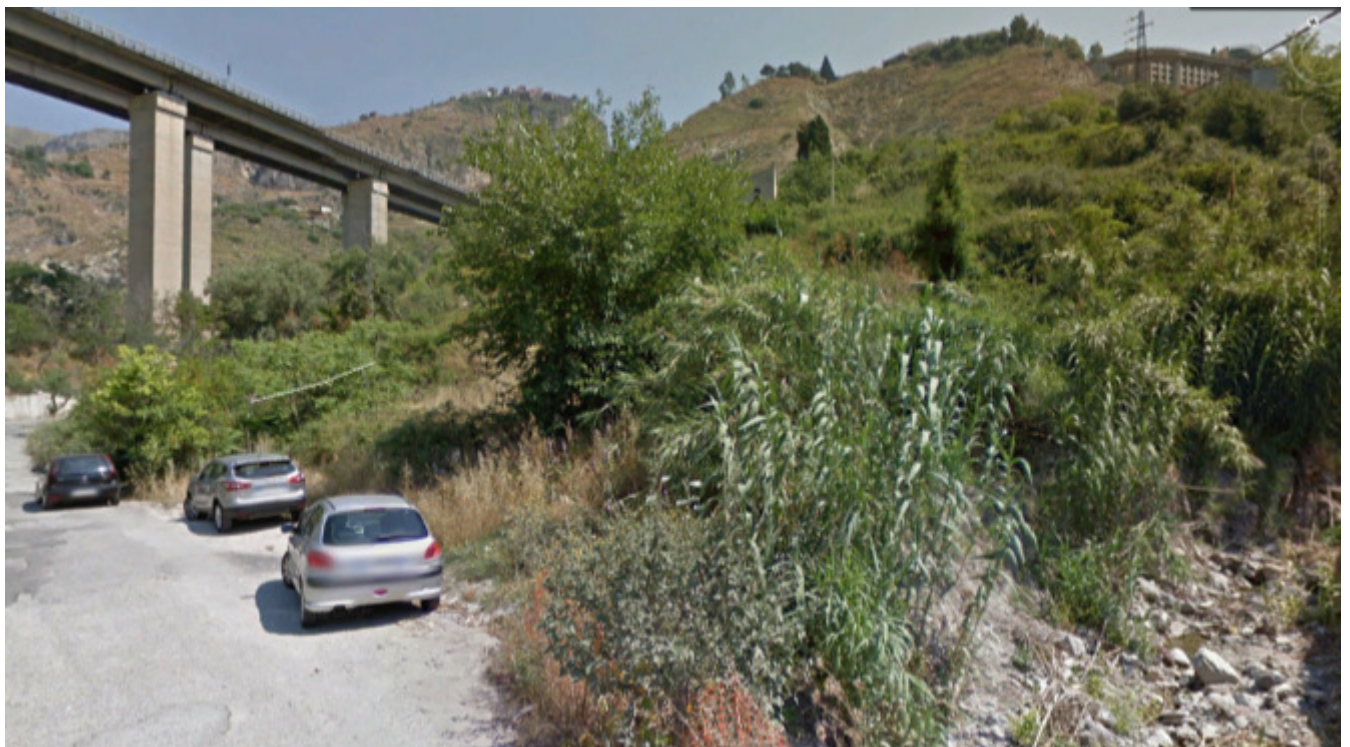
Foto 1 – Vista dell'area tecnica AT10.1 dalla viabilità di accesso
