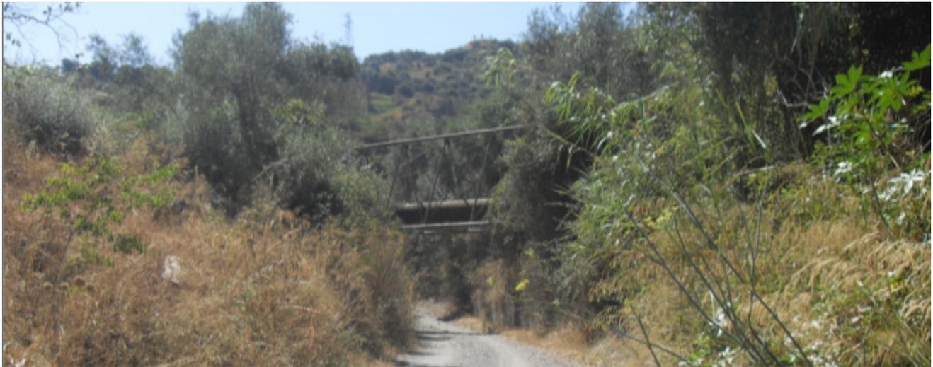
Condotta aerea interferente per il proseguo dei mezzi di cantiere sulla viabilità esistente (H<3,50m)
