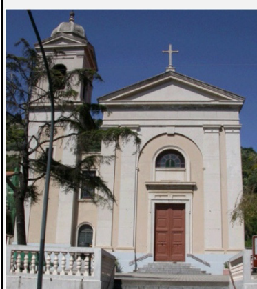
Figura 4-39 Chiesa di S.Giacomo sulla costa nel Comune di Itala in corrispondenza del Km 38+900 ad una distanza di circa 150 m dal tracciato
