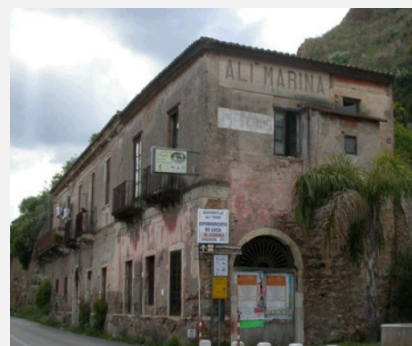
Figura 4-38 Palazzetto signorile sulla costa del Comune di Ali Terme in corrispondenza del Km 35 ad una distanza di circa 478 m dal tracciato.
