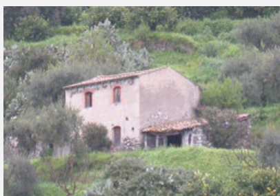
Figura 4-34 Casa rurale nel Comune di Ali Terme al Km 33+350
