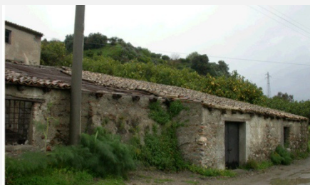
Figura 4-35 Masseria nel Comune di Ali Terme in corrispondenza del tracciato ferroviario al Km 33+420 ad una distanza di circa 160 m dal tracciato
