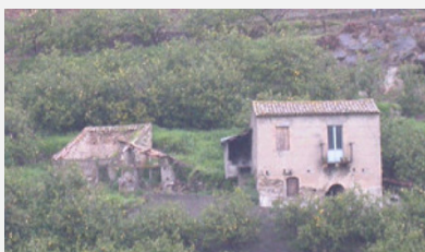
Figura 4-33 Casa rurale nel Comune di Ali Terme in corrispondenza del Km 33+150 ad una distanza di circa 412 m dal tracciato
