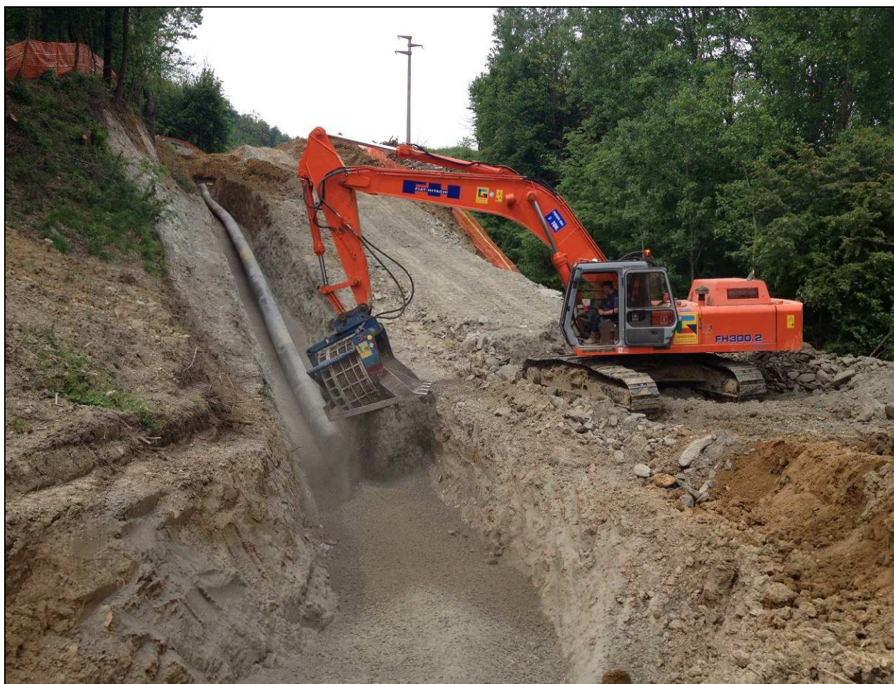
Fig. 8.3 - Operazione di rinterro della condotta.
