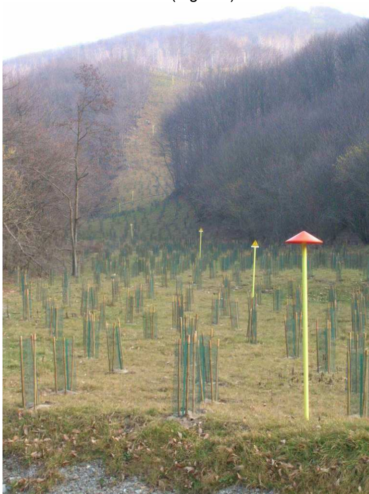
Fig. 8.8 - I cartelli segnalatori di un metanodotto posizionati lungo il tracciato.
