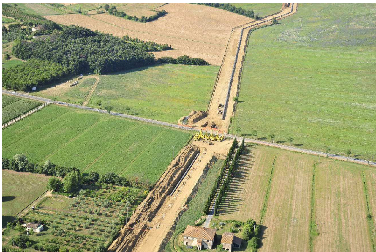
Fig. 8.5 – Panoramica dell'area di un tratto di metanodotto soggetto a TOC per l'attraversamento di un'infrastruttura viaria.
