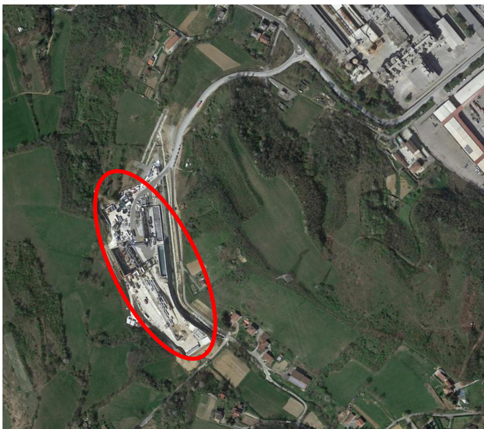
Figura 3 – Localizzazione (cerchiata in rosso) dell'area di cantiere nel progetto approvato
