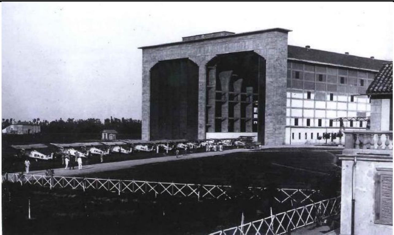
Figura 9 Foto che evidenzia la struttura interna di uno dei due hangars per dirigibili, in grado di ospitarne una copia per ogni edificio. Le enormi porte erano costituite da elementi verticali che si impacchettavano su un lato in fase di apertura. Allineati FIAT CR.20 della 81 a e 88 a Squadriglia, VI Gruppo, 1° Stormo.
