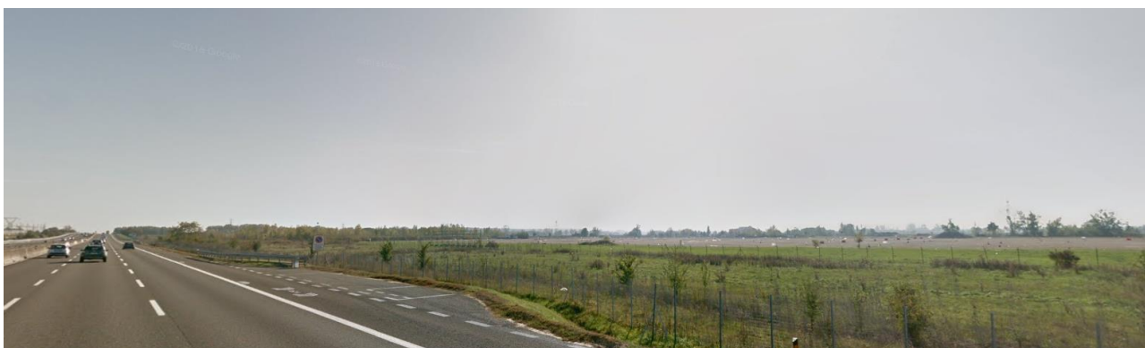
Figura 7-14 Autostrada A1 direzione Reggio Emilia
