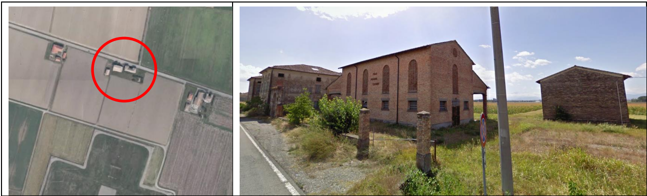
Figura 8-1 Edificio "Podere Casino" interferito dall'estensione della pista
