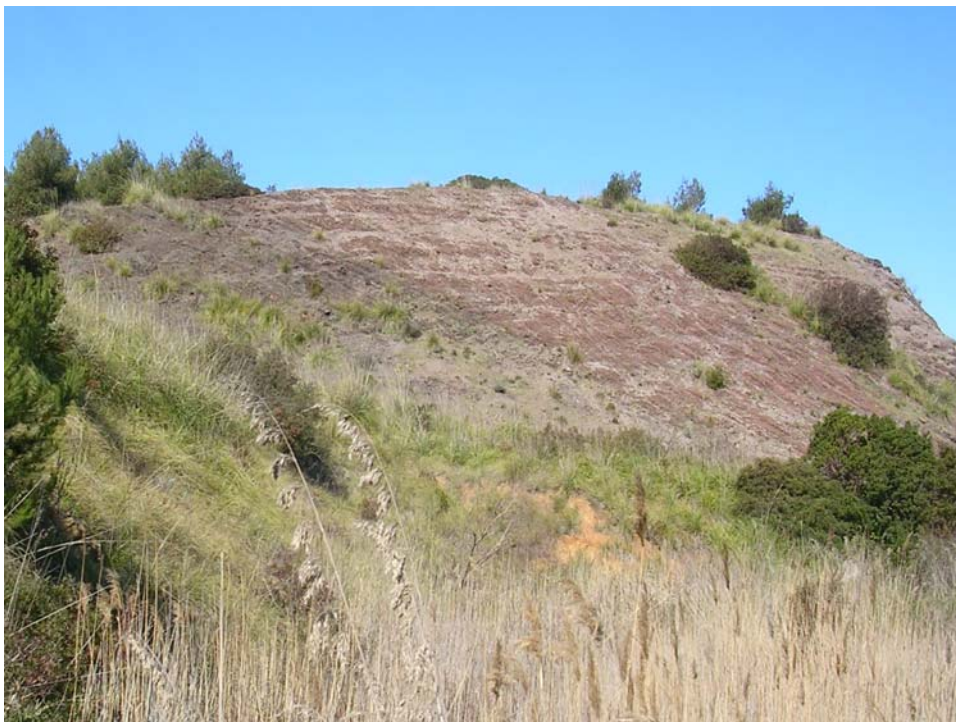
Promontorio costituito interamente da scorie di altoforno, sversate dall'alto e successivamente saldate tra loro (nei pressi dell'asse 1b, progr. km 0+200 - 0+300 circa; foto scattata da SE).
