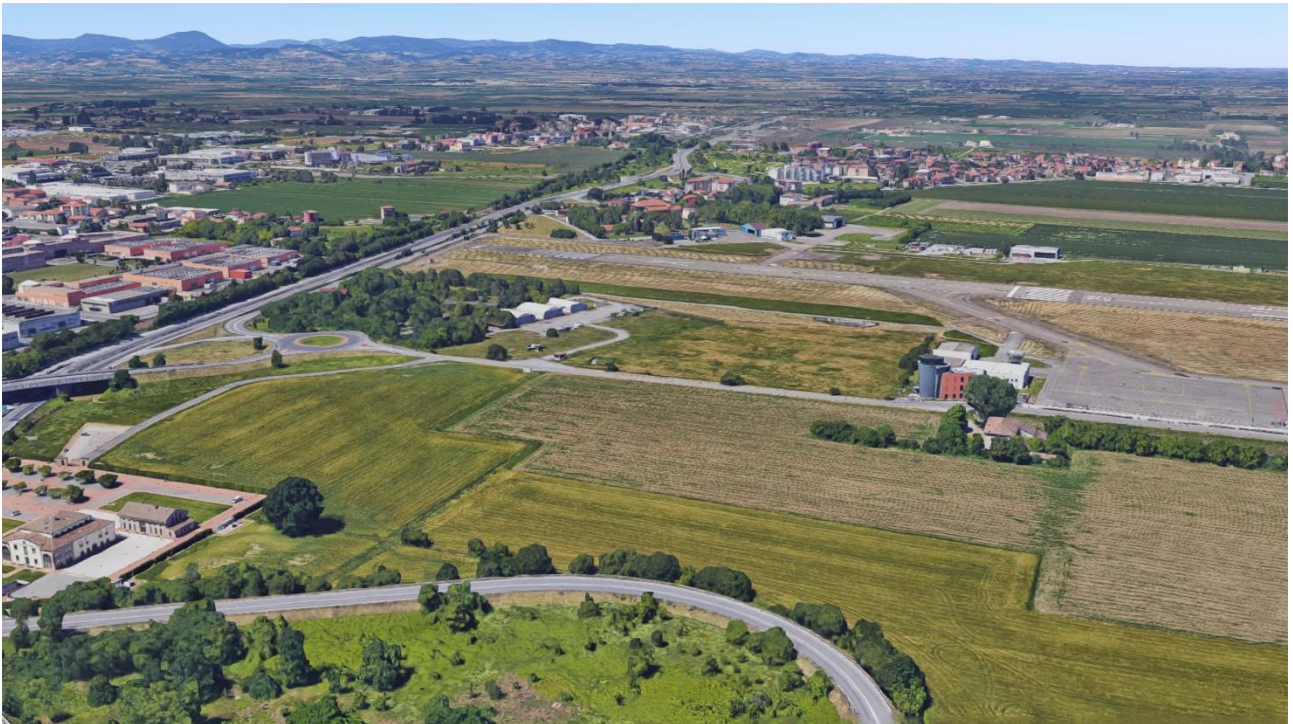
Figura 4-15 Vista sud dell'area del Polo Cargo – ante operam a volo d'uccello
