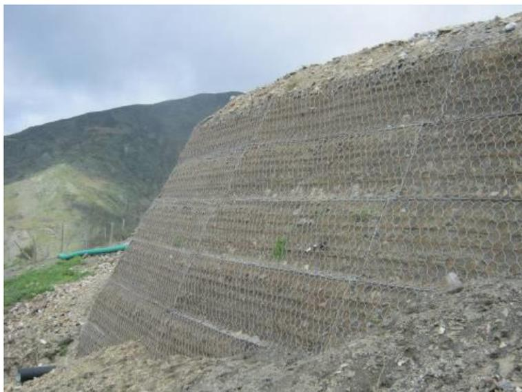
Figura 16 Esempio di opera in terre rinforzate - Fonte HE
