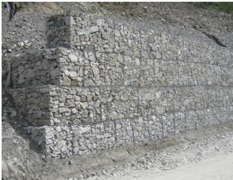
Figura 17 Esempio di opera in gabbioni - Fonte HE
