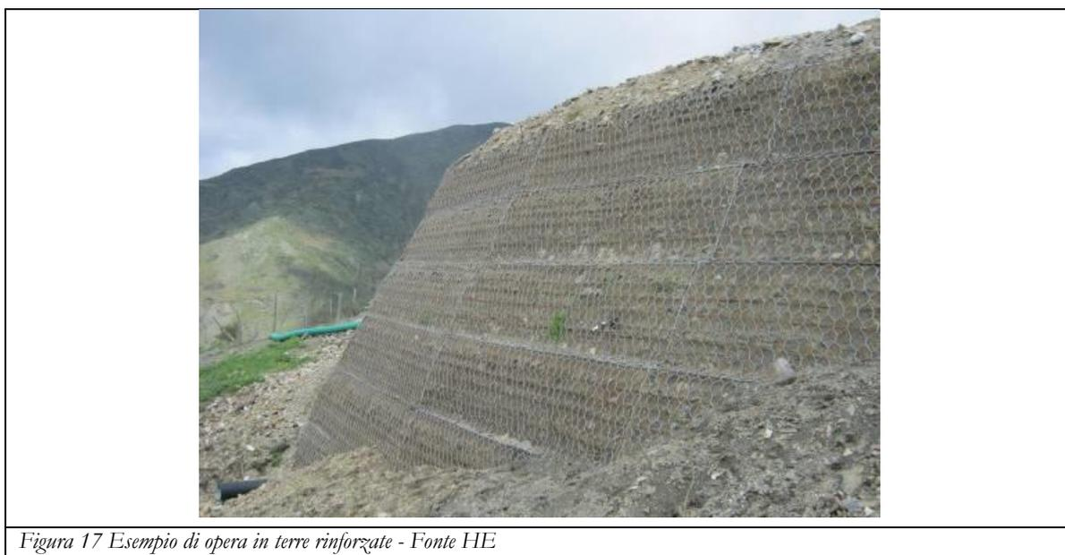
Figura 17 Esempio di opera in terre rinforzate - Fonte HE
