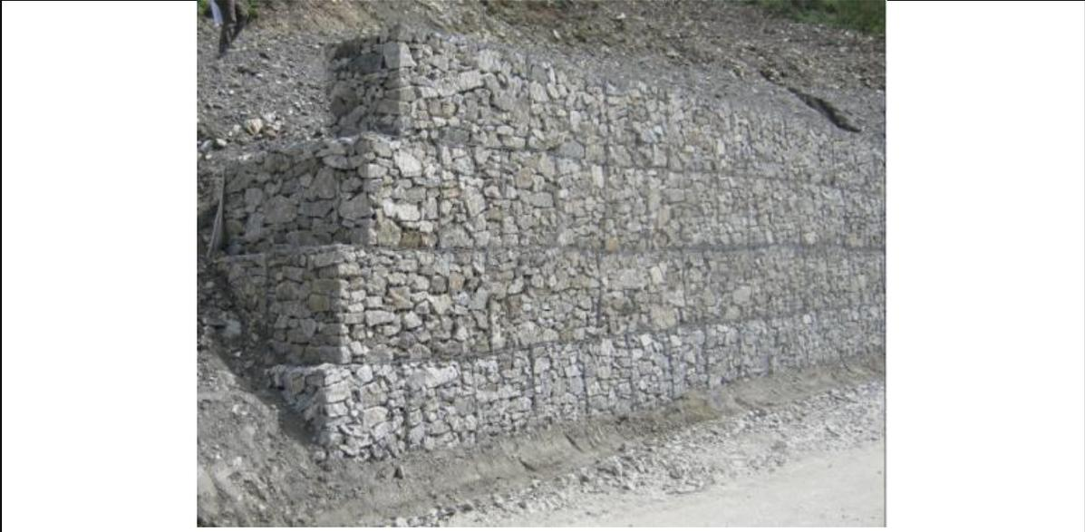
Figura 18 Esempio di opera in gabbioni - Fonte HE
