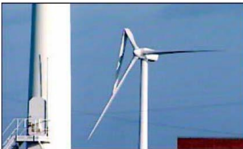
Esempio di rottura di pala senza distacco.
