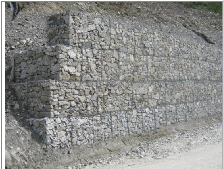
Esempio di opera in gabbioni - Fonte HE
