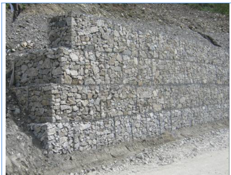
Esempio di opera in gabbioni - Fonte HE
