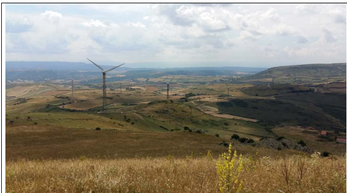
Panoramica di parte del parco eolico esistente acquisita con Drone – fonte HE
