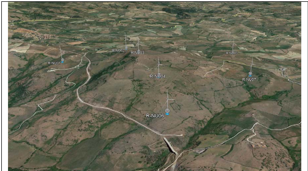
Vista degli aerogeneratori (da sinistra verso destra) R-NU01, R-NU02, R-NU03, R-NU04, R-NU05, R-NU06- R-NU07
