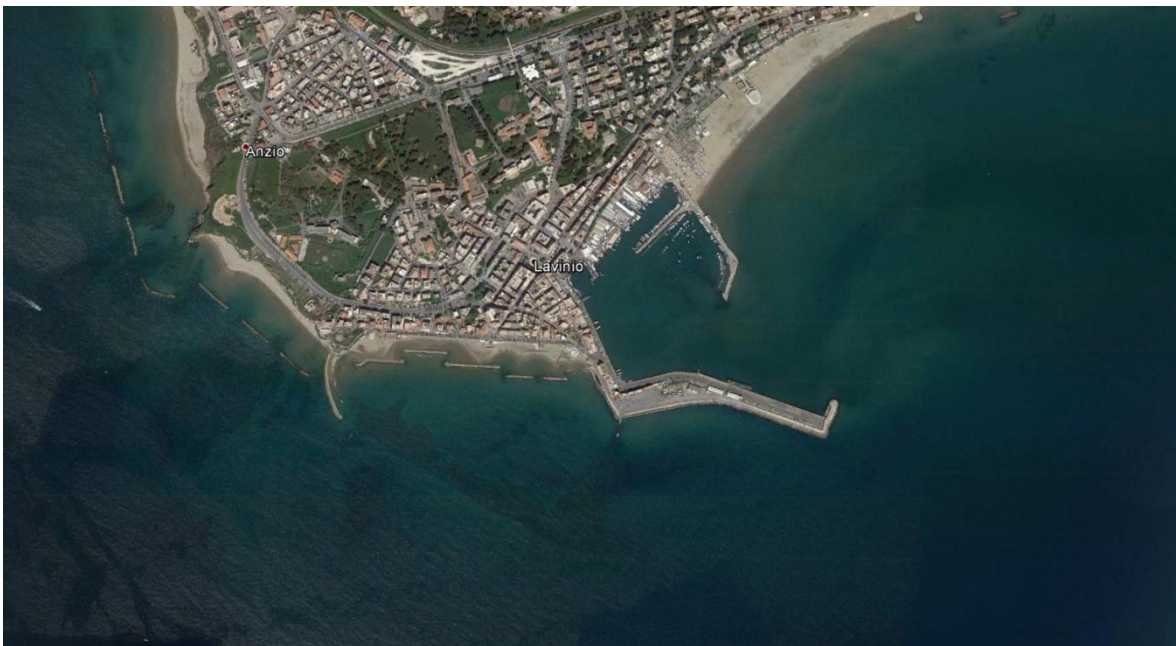
Figura 1 - Foto dell'area portuale di Anzio oggetto degli interventi di Fase 3
