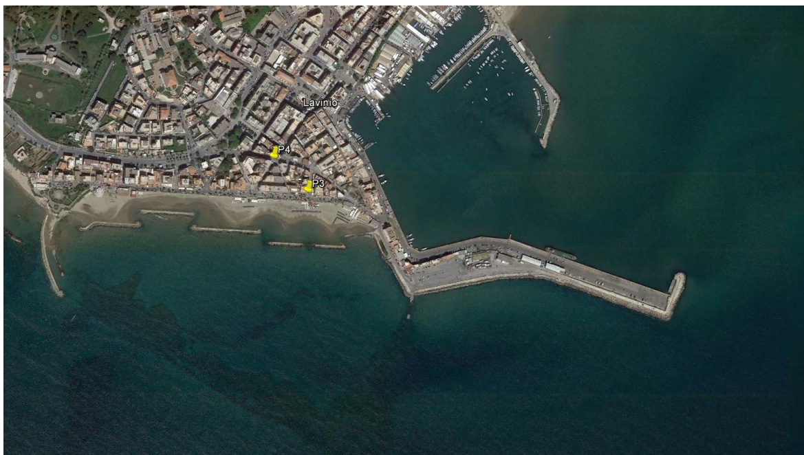
Figura 4. Postazioni di misura del rumore dovuto alla viabilità in fase di esercizio
