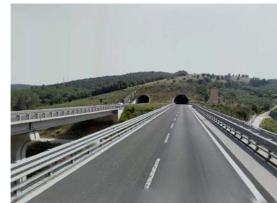
Viadotto Val della Petraia e galleria Poggio Bastione
