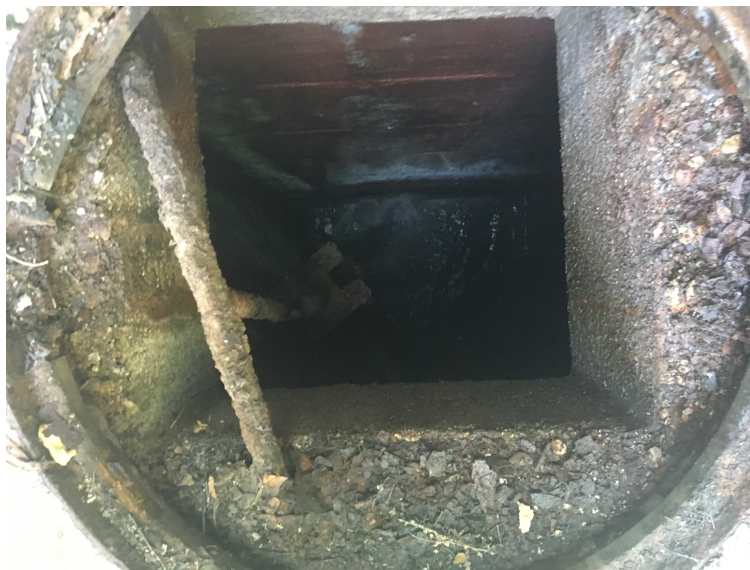
Figura 6 – Fogna mista BA15 pk AV 15+980 (81+462.08 BP) lato sud
