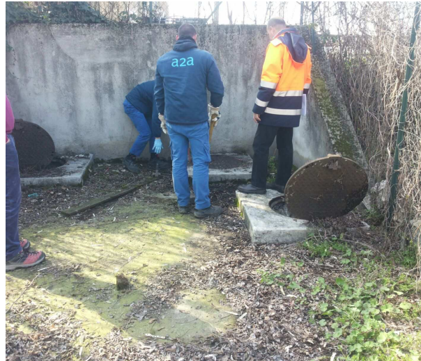
Figura 7 – Sopralluogo congiunto con il personale A2A
