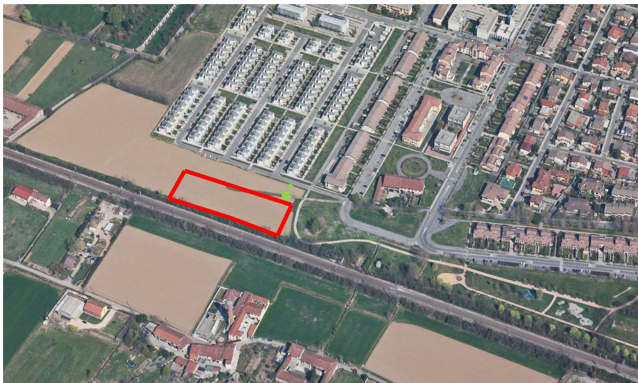
Vista dell'area tecnica 6
