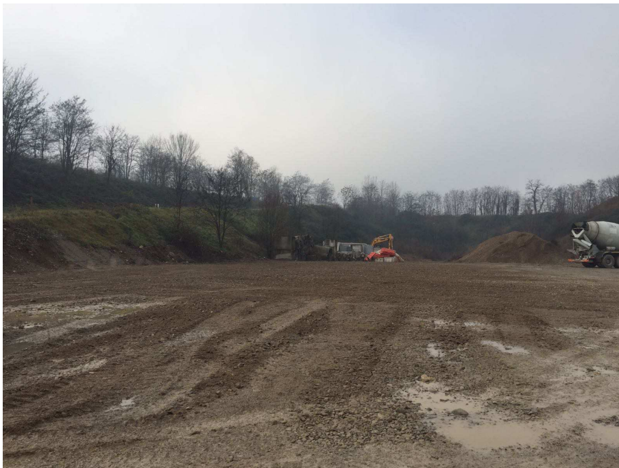
Viste dell' area Cantiere Base
