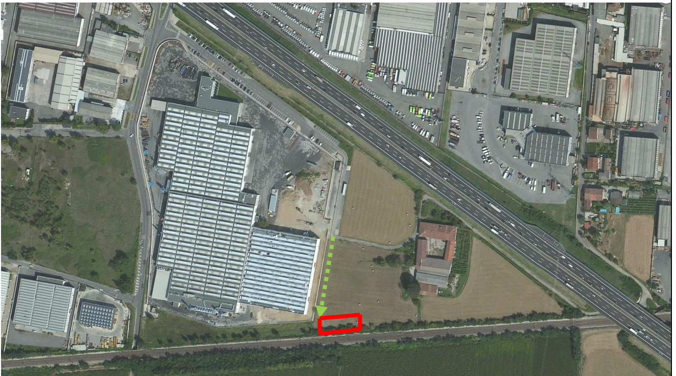
Vista dell' area tecnica 1
