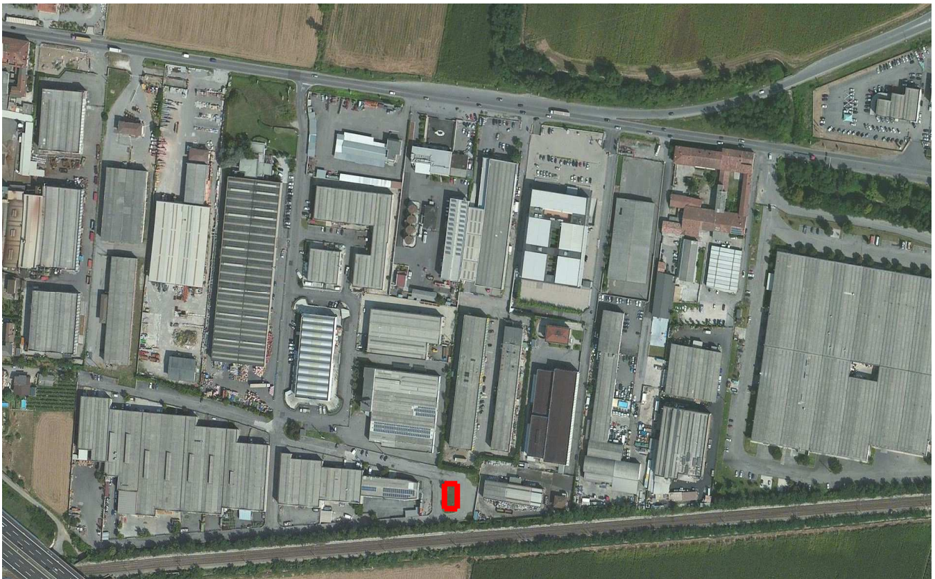
Vista dell' area tecnica 2
