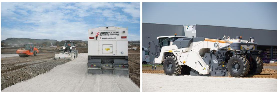
**Figura 5-1 Esempio di macchine spandilegante e macchine stabilizzatrici**
