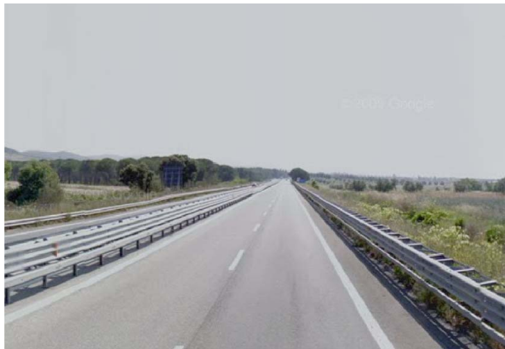
Figura 2: Tratto in corrispondenza dell'inizio del lotto 3
