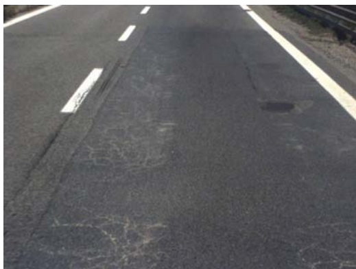
Figura 1 - Fessure a pelle di coccodrillo (FPM) Figura 2 - Fessurazioni longitudinali (FL)
