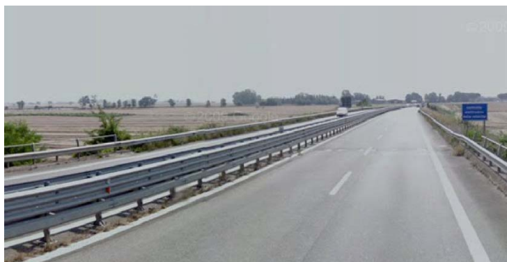
Figura 5: la SS1 in corrispondenza del viadotto Bruna
