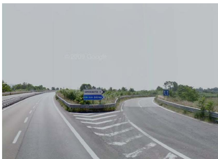
Figura 9: Svincolo Grosseto Roselle
