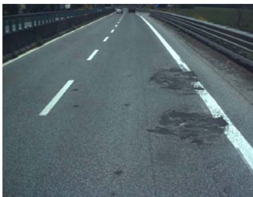
Figura 3 - Ammaloramenti localizzati (AL) Figura 4 – Risalita materiale fine (RF)
