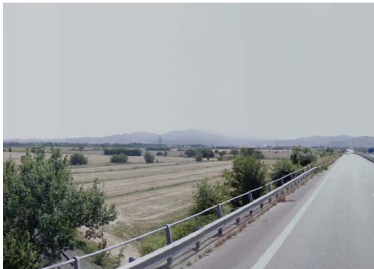
Figura 4: La SS1 in corrispondenza del viadotto FF.SS. Giuncarico-Ribolla
