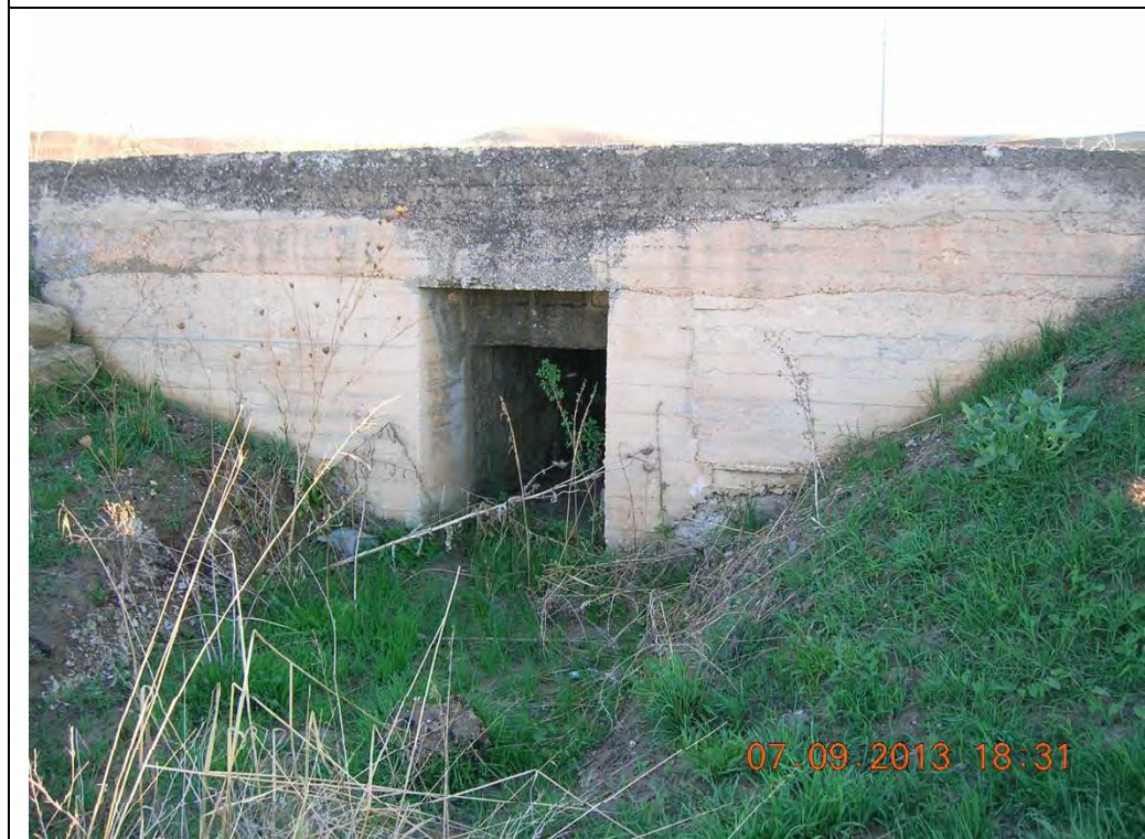
PARTICOLARE REALIZZATIVO DELL'ATTRAVERSAMENTO STAFFAGGIO A PONTE (LATO DI VALLE) ELABORATO 8 Particolare N. 4
