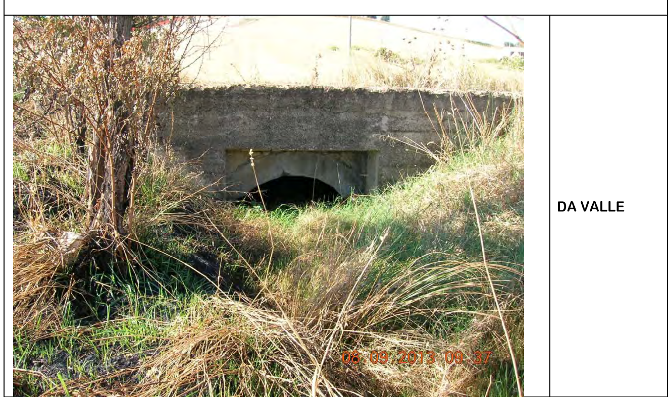
PARTICOLARE REALIZZATIVO DELL'ATTRAVERSAMENTO STAFFAGGIO A PONTE (LATO DI VALLE) ELABORATO 8 Particolare N. 5
