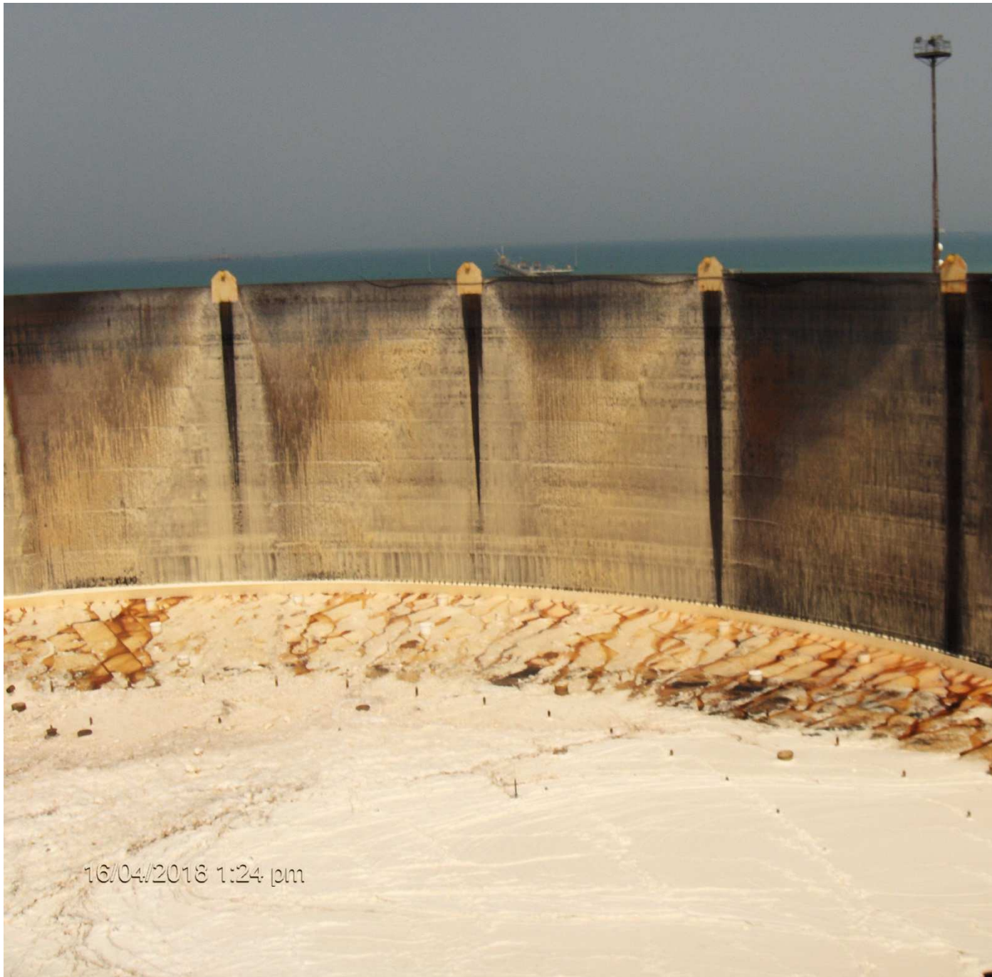
Figura 1 tetto tk 61 con prodotto sotto letto di schiuma
