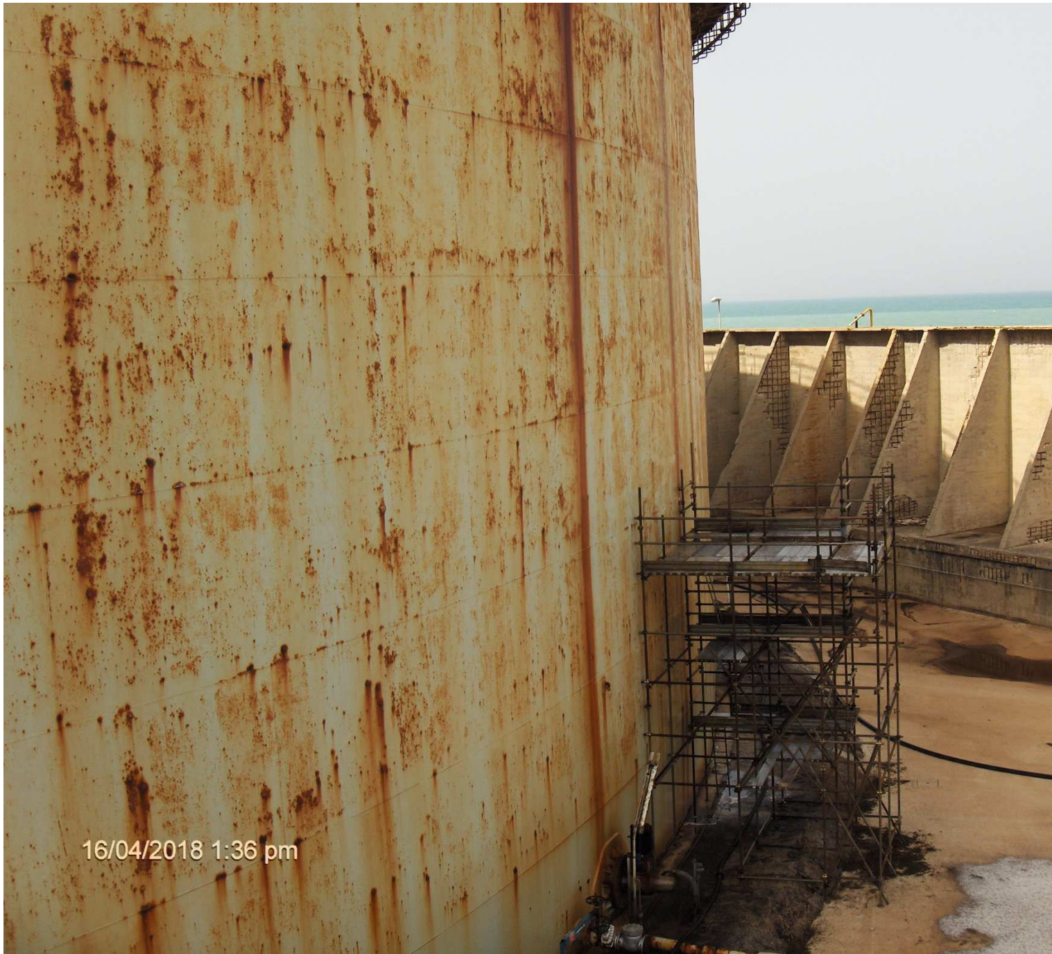
Figura 7 ponteggio per istallazione sistema di idrotaglio
