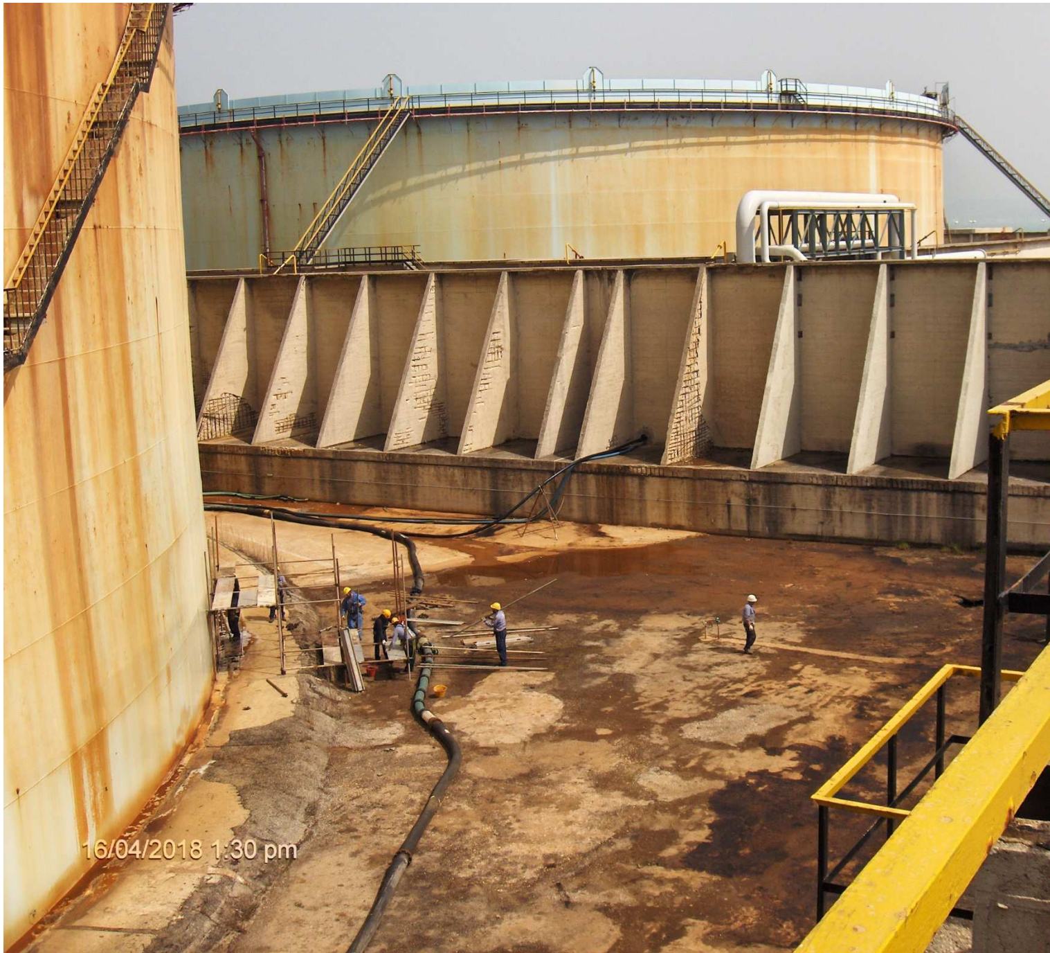
Figura 13 bacino di contenimento tk 61 con tubi del circuito di aspirazione del prodotto idrocarburico dal tetto
