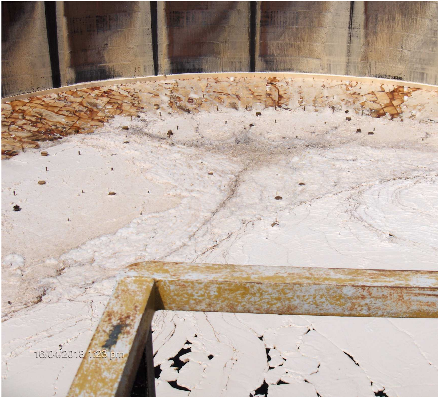
Figura 4 tetto tk 61 con prodotto sotto letto di schiuma
