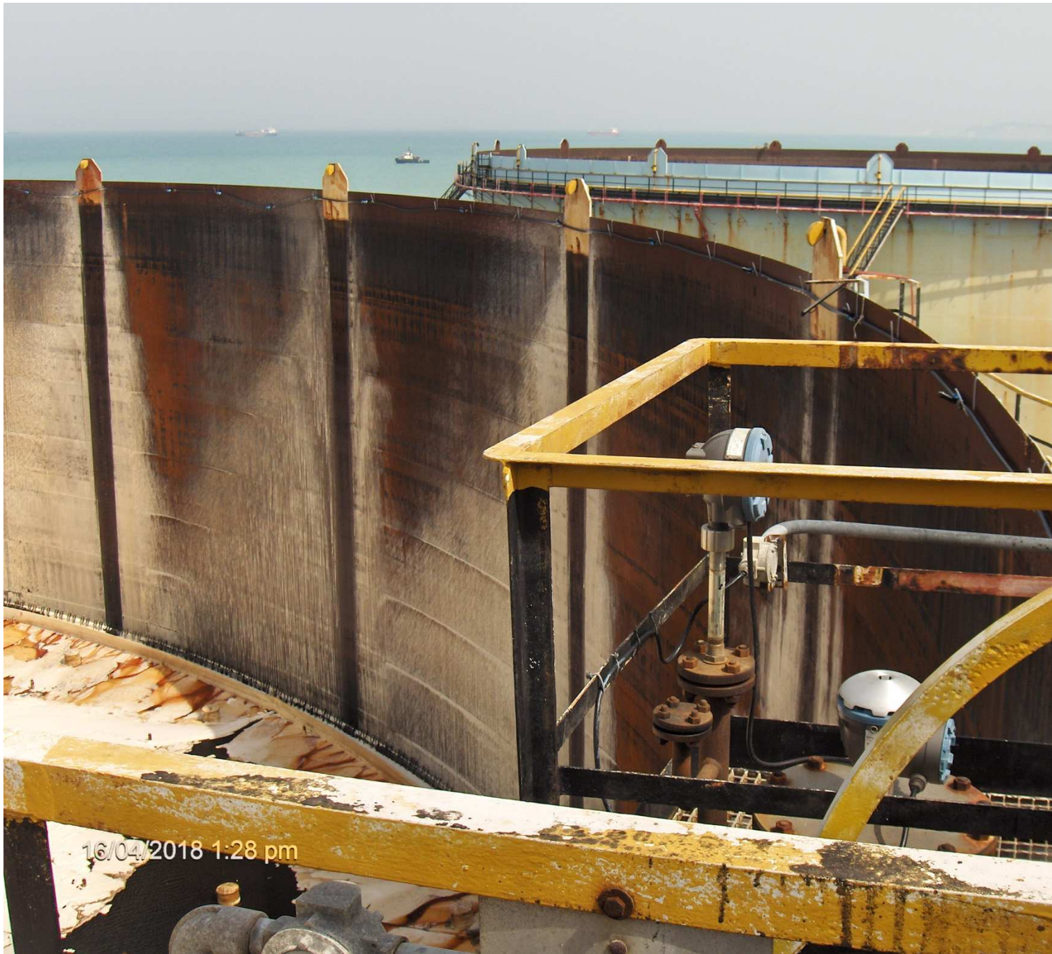
Figura 14 particolare del circuito di spruzzamento sostanze sequestranti lato Ancona
