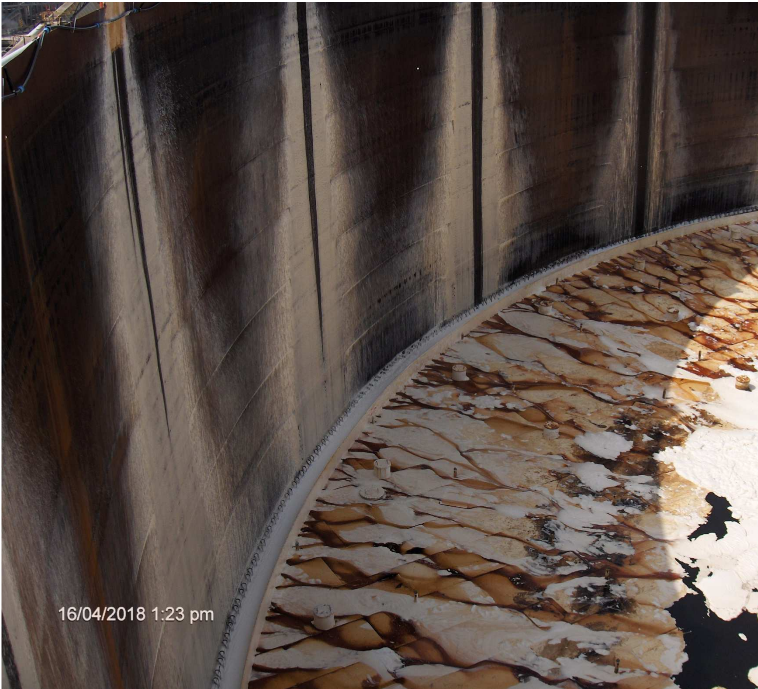
Figura 3 tetto tk 61 con prodotto rimosso
