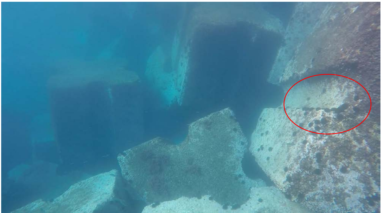
Figura 9 – Porto di Catania: Molo di Levante lato esterno. Piano infralitorale caratterizzato dalla zona di pascolo (barren) dei ricci di mare (cerchiati in rosso), a livello dei massi in calcestruzzo che occupano la porzione di fondale che va da appena al di sotto la superficie del mare sino ai -5/6m.
