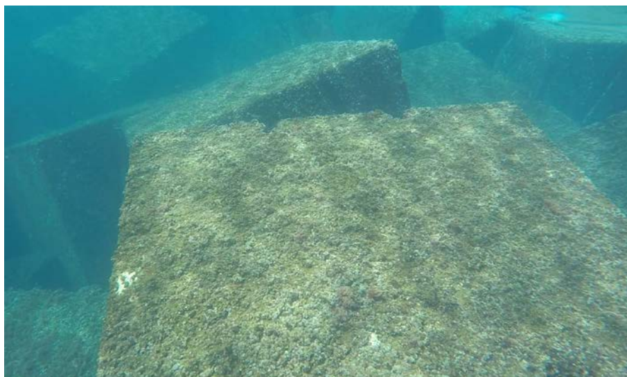
Figura 7 – Porto di Catania: Molo di Levante lato esterno. Masso in calcestruzzo ricoperto di feltri biologici, caratterizzati dall'insieme di forme incrostanti animali e vegetali.
